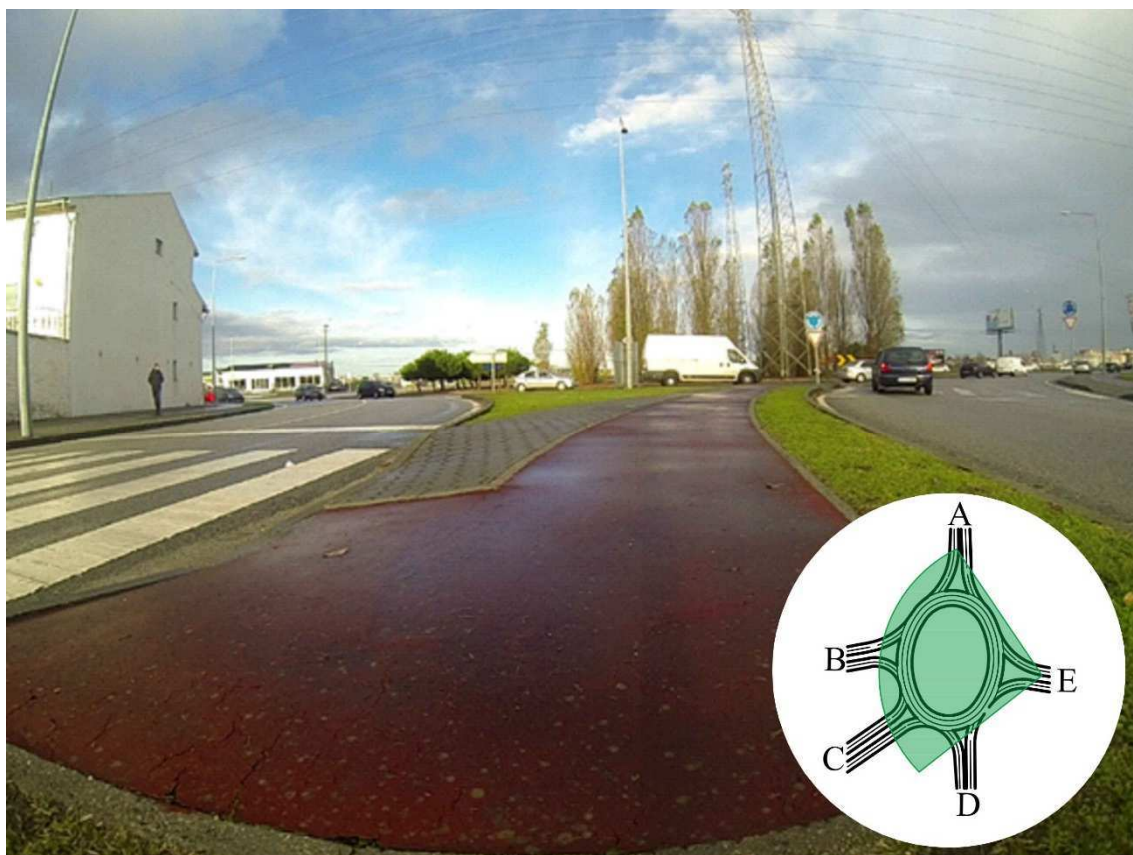
Figura 21 - Vista da Câmara 5
