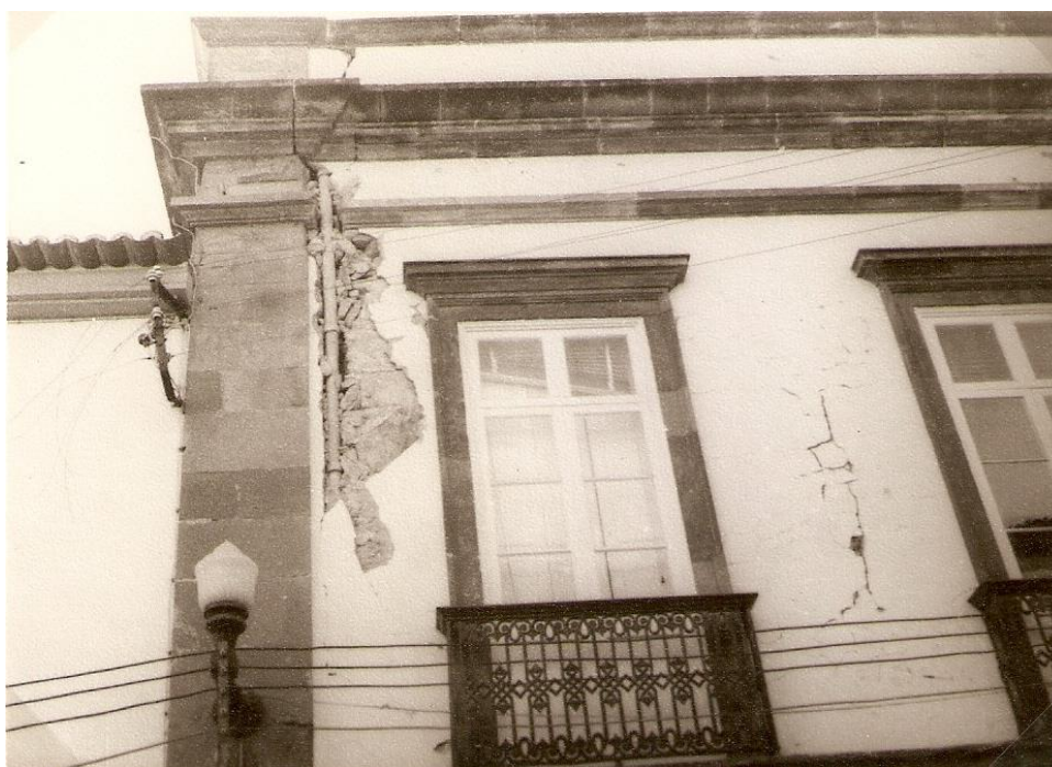
Figura 6.11 Edifício original após sismo de 1980
