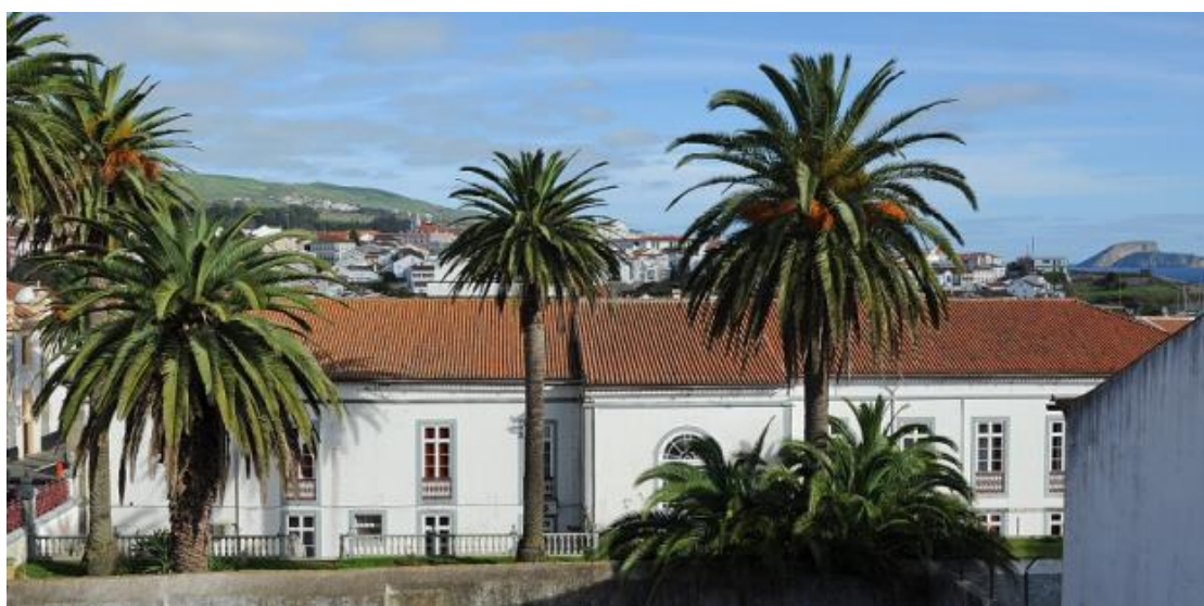
Figura 3.3 Configuração atual do Edifício Paços da Junta Geral – fachada tardoz
