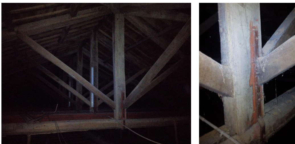
Figura 3.12 Estrutura da cobertura – edifício original
