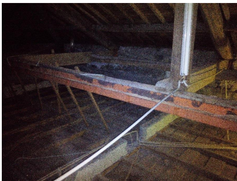
Figura 3.16 Tirante (cobertura) – obras de reforço estrutural
