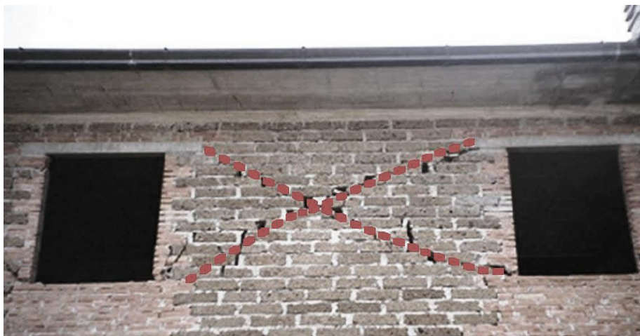
Figura 6.2 Exemplo de dano associado ao corte [34]
