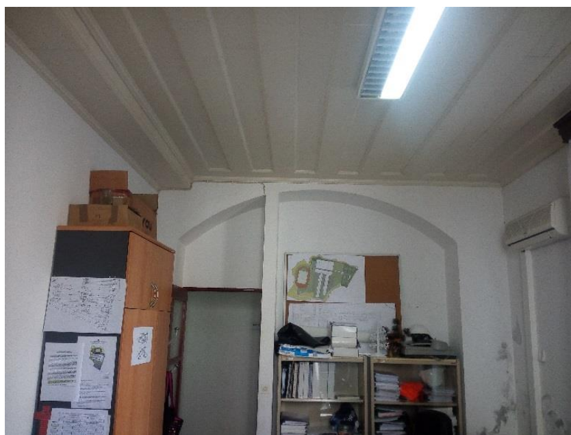
Figura 3.10 Parede em arco – edifício original (ala norte)
