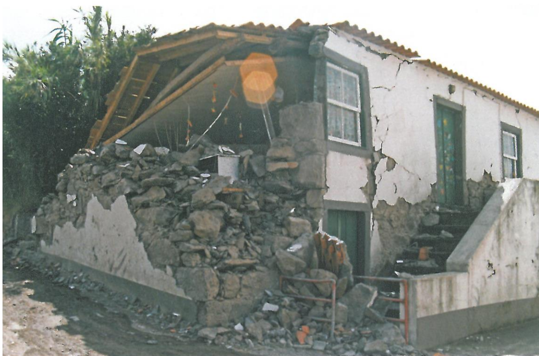
Figura 2.13 Colapso da estrutura da cobertura de um edifício habitacional (localização desconhecida) [2]
