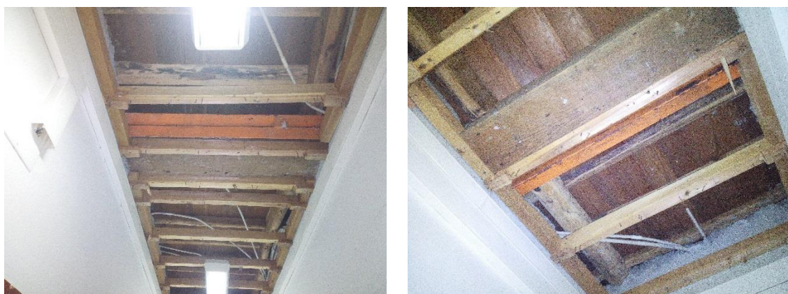
Figura 3.11 Estrutura do pavimento – edifício original (ala norte)
