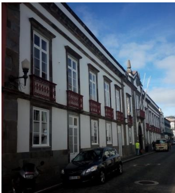
Figura 3.2 Configuração atual do Edifício Paços da Junta Geral – fachada principal
