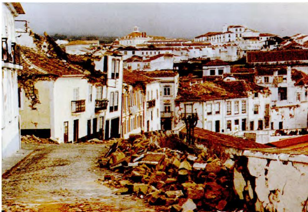
Figura 2.7 Danos nas construções ao longo da Rua da Rocha (Angra do Heroísmo) [6]
