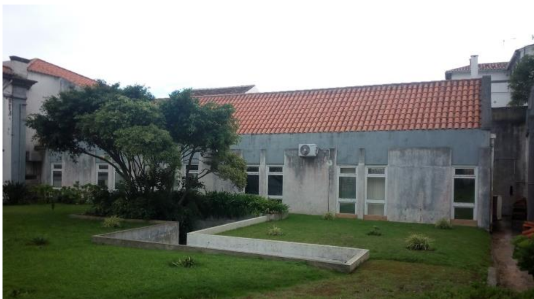
Figura 3.18 Obras de ampliação – zona posterior
