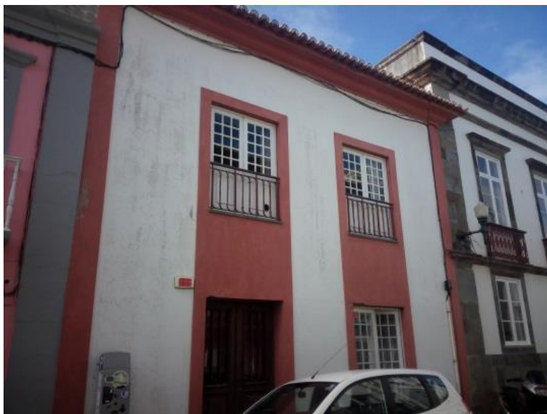
Figura 3.17 Obras de ampliação – fachada da zona anterior
