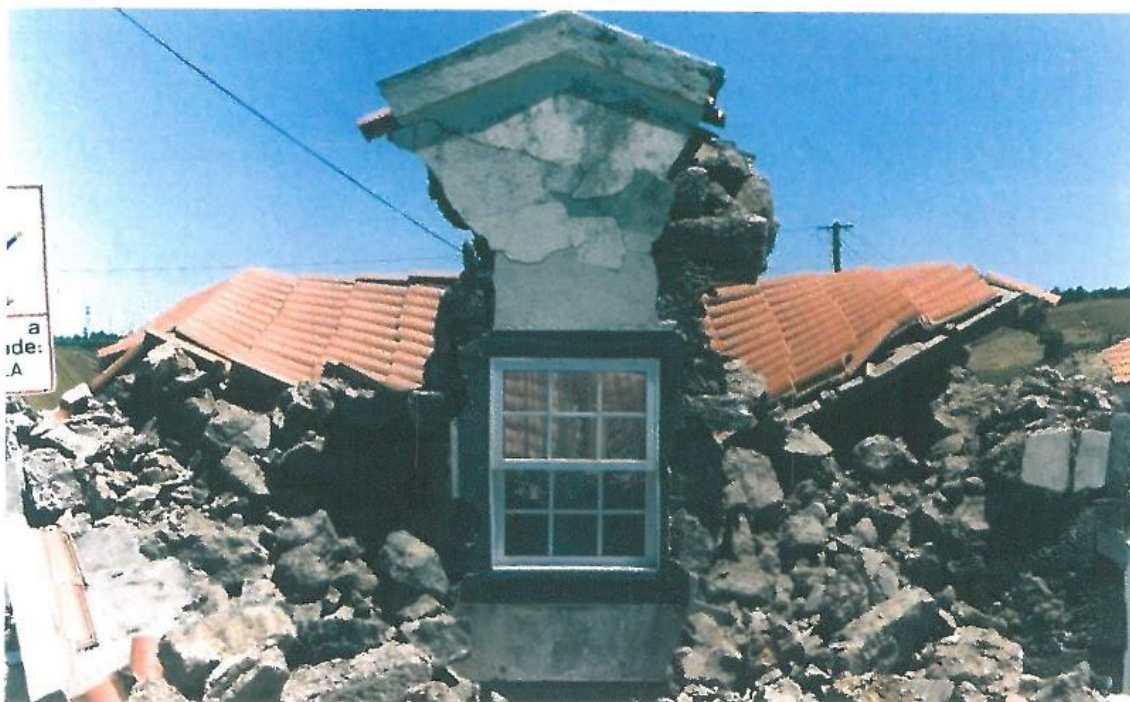
Figura 2.13 Colapso da estrutura da cobertura de um edifício habitacional (localização desconhecida) [2]
