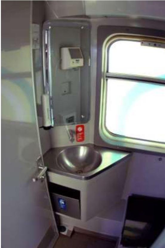
Fotografia 50. Interior do cúbiculo WC SM. O corpo escuro no canto inferior direito é a tampa da sanita. A superfície à esquerda da janela, e por cima do lavatório, é um espelho.
