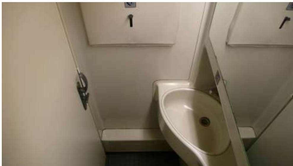
Fotografia 97. Cubículo CPA. Vista do interior. À esquerda observa-se a porta do cubículo (fechada). A superfície acima do lavatório é um espelho)
