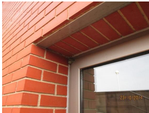
Fig. 6.27 - Lintél metálico (UA)
