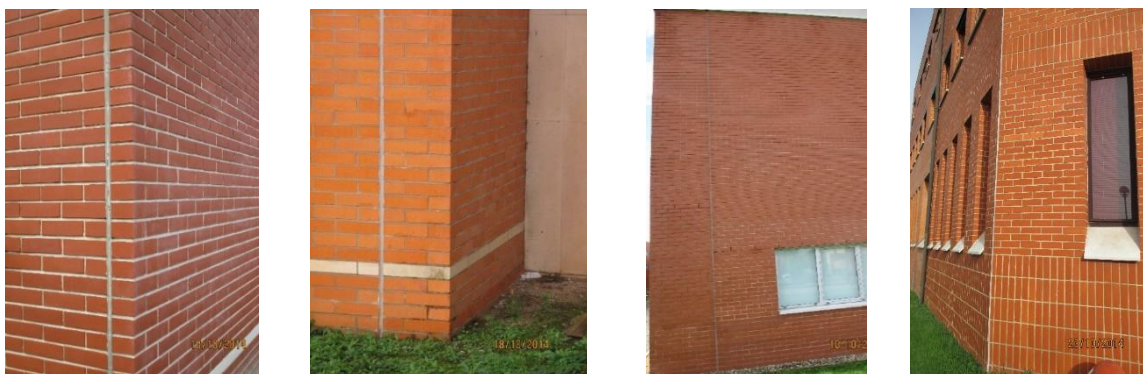
Fig. 6.5 - Juntas de movimento em cunhais sem ocorrência de patologia (UA)
