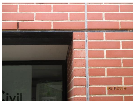
Fig. 6.31 - Vão com aplicação de lintel e junta de movimento vertical (UA)
