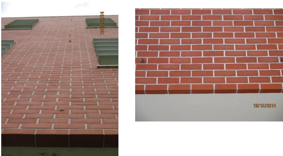
Fig. 4.9 – Orifícios salientes para drenagem da caixa-de-ar, Departamento de Matemática (UA)
