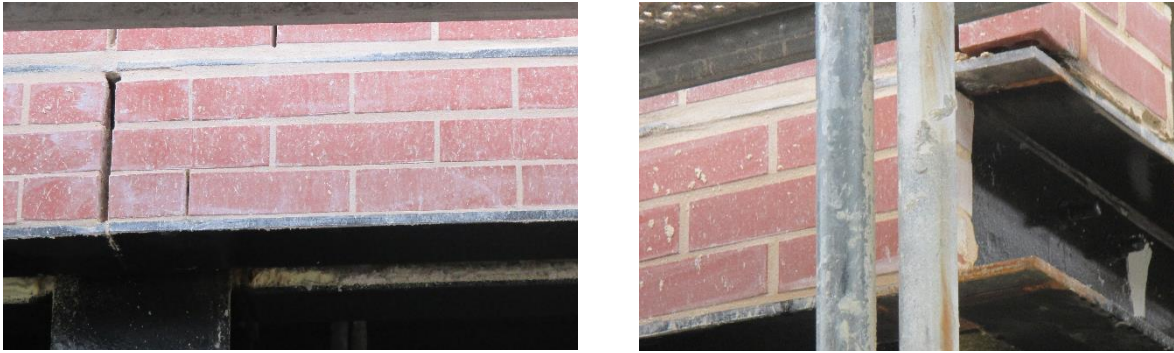
Fig. 5.4 – Arranque do pano exterior em TFV (UA)
