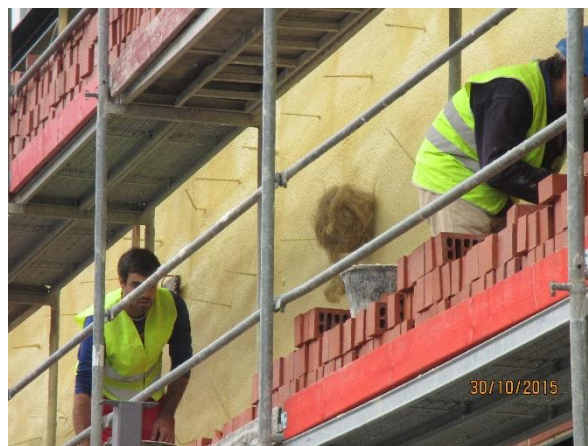
Fig. 4.12 - Construção do pano exterior em tijolo face à vista, com isolamento e grampos ainda observáveis.
