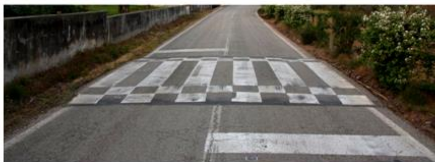
Figura 63. Travessia pedonal elevada, apresentando características geométricas para serem reconhecidas pelos utentes da via (Fonte: http://aventar.eu )
