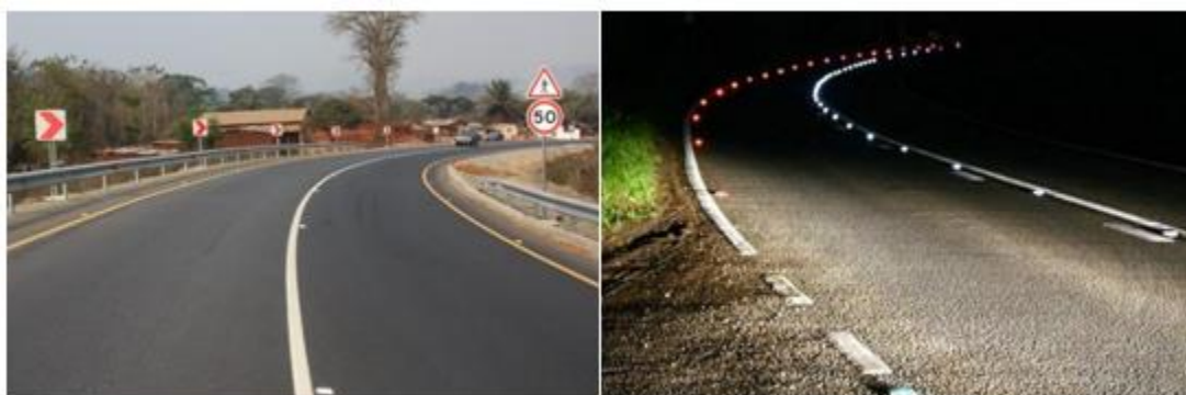
Figura 70. Colocação de marcadores no pavimento (Fonte: www.bricantel.pt )
