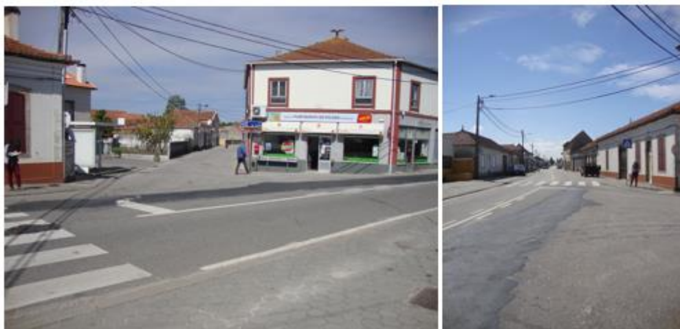
Figura 107. Passadeira existente na interseção da Rua dos Louros com a Rua Direita
