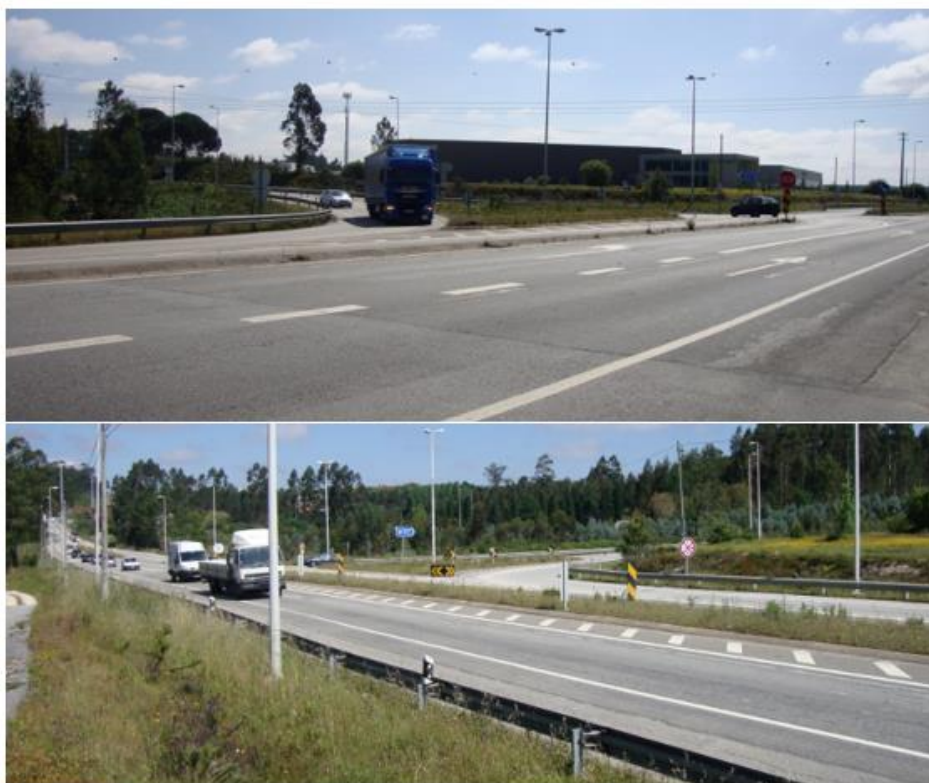
Figura 94. Interseção da EN235 do lado norte (em cima) e lado sul (em baixo)
