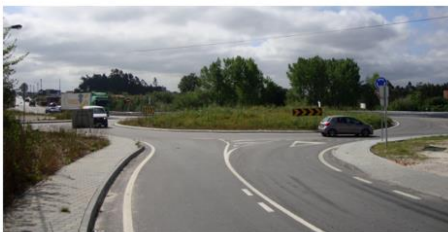
Figura 86. Recente rotunda construída na interseção no lugar do ilhéu
