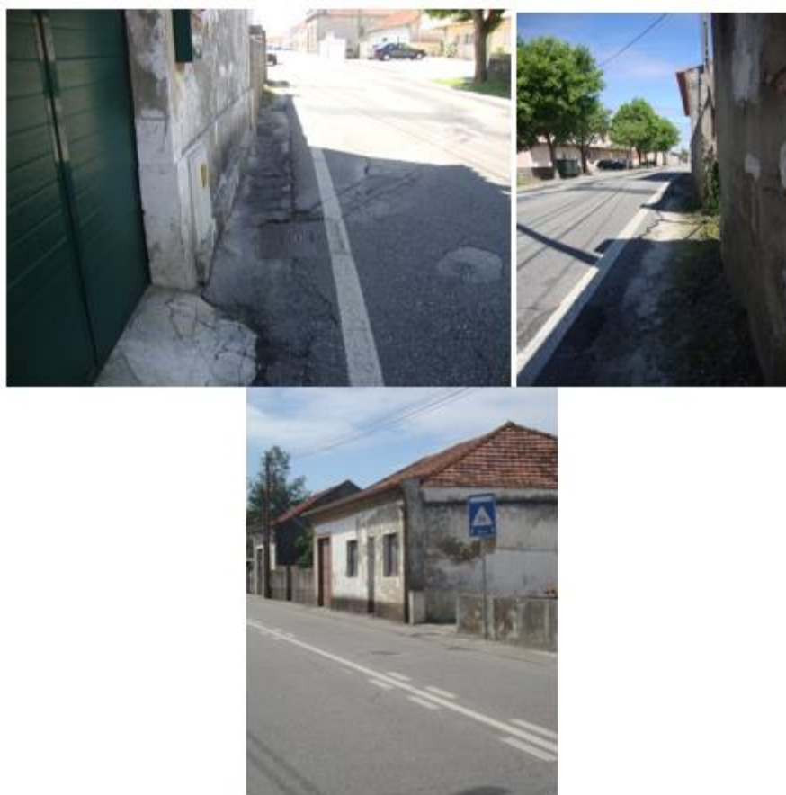
Figura 101. Locais sem passeios (fotografias em cima), passeio com altura diminuta (fotografia em baixo)
