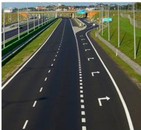
Figura 67. Via de desaceleração (Fonte: www.autogreen.pt )
