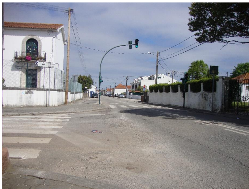
Figura 111. Travessia pedonal semaforizada junto à interseção da Rua da Carregueira com a Rua Direita em Aradas
