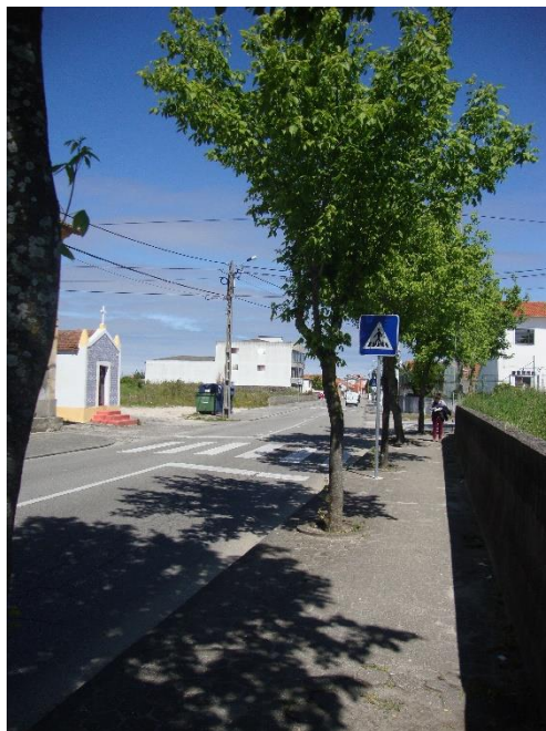
Figura 115. Sinal de indicação de passadeira obstruído pelos ramos de árvore
