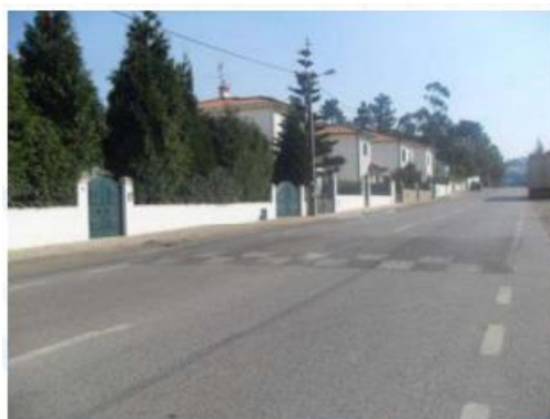
Figura 61. Lomba redutora de velocidade numa zona residencial (Fonte: InIr, 2011a)
