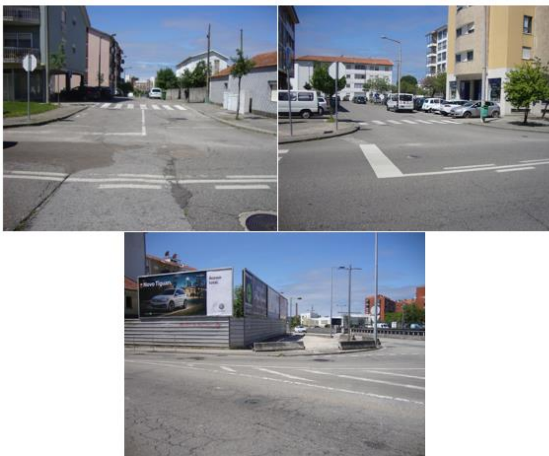
Figura 118. Interseção da Rua de Trás com a Rua Direita (em cima à esquerda), interseção da Travessa do Eucalipto Sul (em cima à direita) e entrada para a Rua Direita junto á rotunda da EN109 (em baixo)
