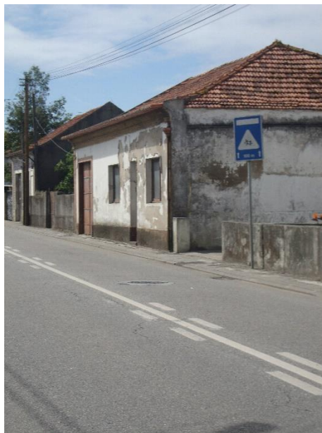
Figura 110. Sinal de indicação de aproximação de escolas mal colocado e em mau estado de conservação
