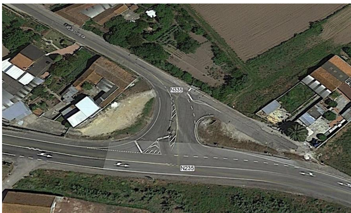
Figura 84. Antiga interseção existente na EN235 (Fonte: Google Earth, 2016)
