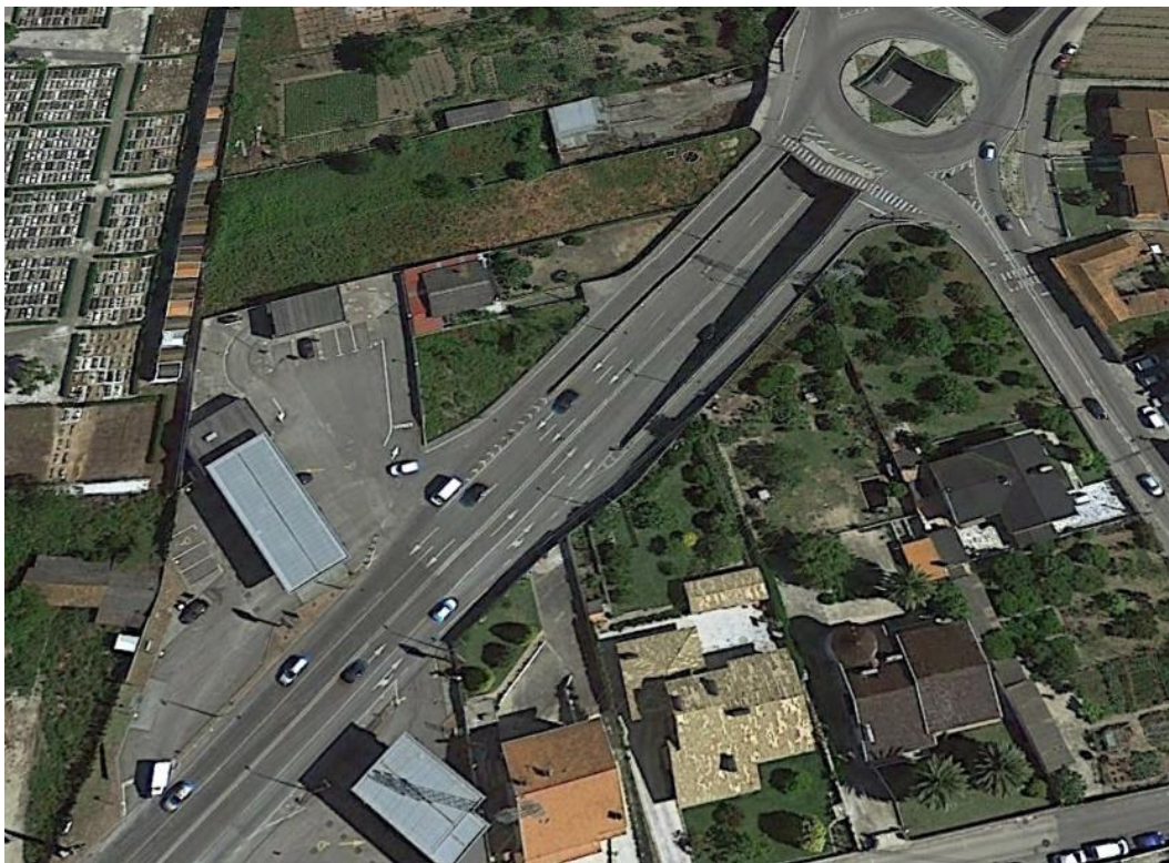
Figura 77. Local de estudo da EN109 no sentido norte-sul, onde se situa a via precedente da rotunda desnivelada com acesso ao posto de abastecimento (Fonte: Google Earth, 2016)
