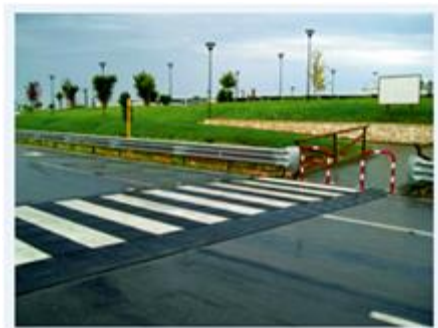
Figura 62. Travessia pedonal elevada, sendo notória a forma trapezoidal (Fonte: www.construir.pt )
