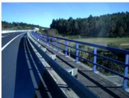
Figura 64. Exemplo de barreira de segurança (Fonte: InIr, 2010)
