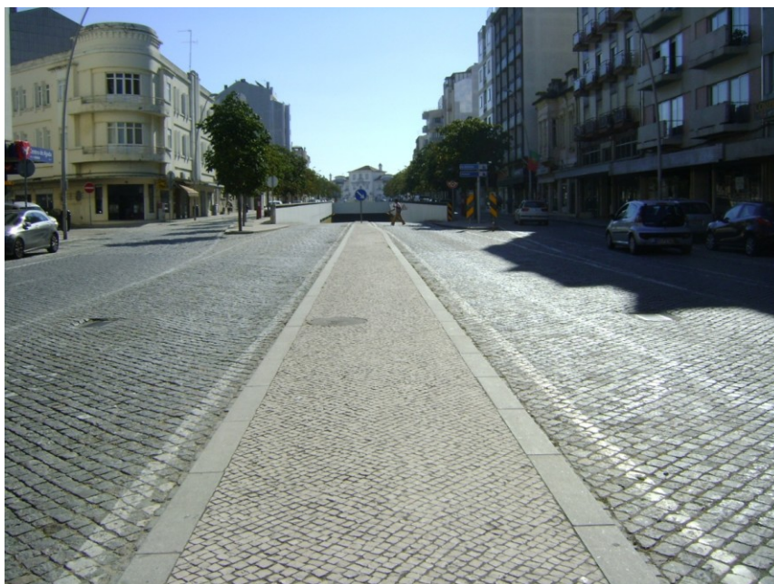
Fig. D.21 – Túnel no fim da ALP que passa por baixo da Estação de comboios
