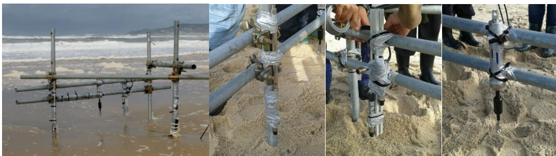
Figura 4.2: Tripé para a instalação dos instrumentos, seguida de um transdutor de pressão (Level Troll 500), sensor ótico (Campbell) e correntómetro eletromagnético (Infinity) na Campanha de novembro 2014.
