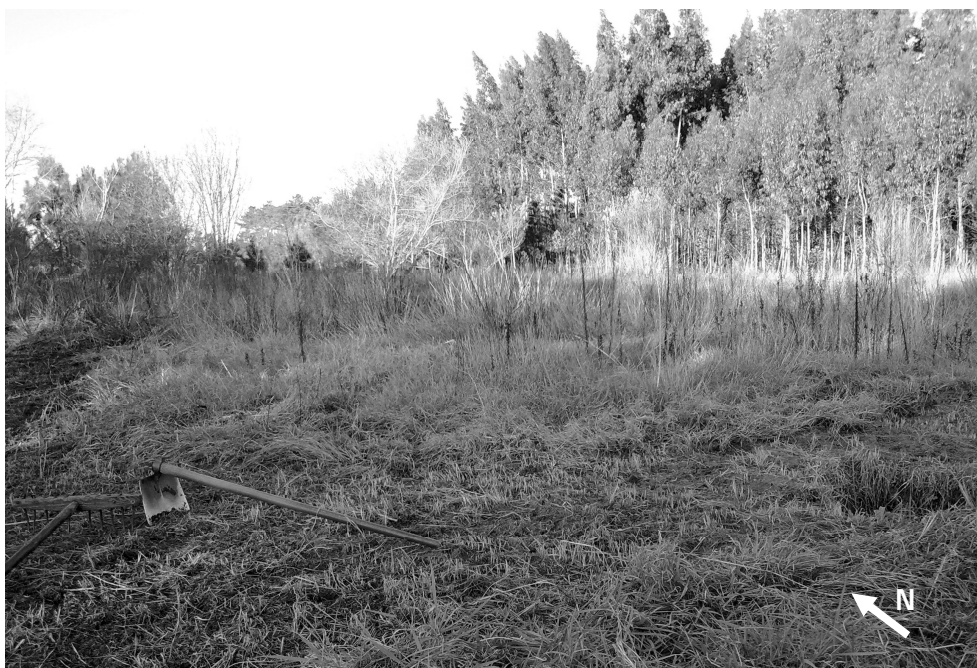
Figura 4.4 – Limpeza e desbaste inicial do terreno.
