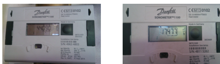
Figura 42 – Sistemas de monitorização do caudal de água de aquecimento. Sistemas estáticos e compactos de ultrassons para medição de energia – Sonometer™ 1100 da Danfoss (cortesia Ventil – Engenharia do Ambiente, Lda.).
