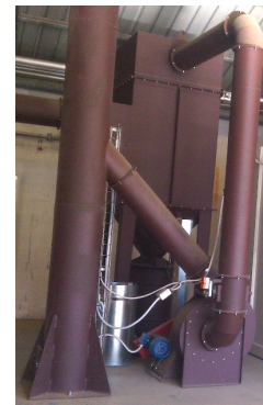
d) Toma de medição na conduta de ligação entre o ventilador de tiragem forçada e a chaminé.
