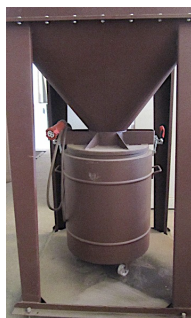
Figura 30 – Balde de recolha de cinzas volantes recolhidas nos ciclones individuais do multiciclone (cortesia Ventil – Engenharia do Ambiente, Lda.).
