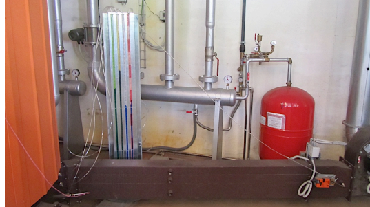
Figura 60 - Prolongamento da conduta de introdução de ar de combustão na fornalha com secção de amostragem (cortesia Ventil – Engenharia do Ambiente, Lda.).
