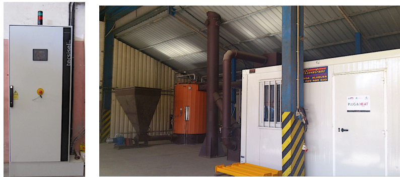
Figura 33 – Sistema de aquisição de dados, controlo e monitorização do sistema de combustão (cortesia Ventil – Engenharia do Ambiente, Lda.).
