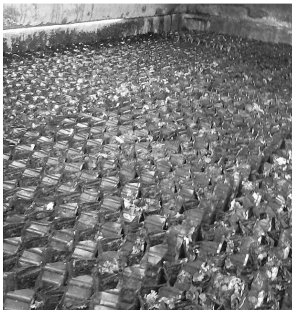
Figura 12: Enchimento das torres de refrigeração de água da unidade de regeneração de solventes da EGEO Solventes S.A.
