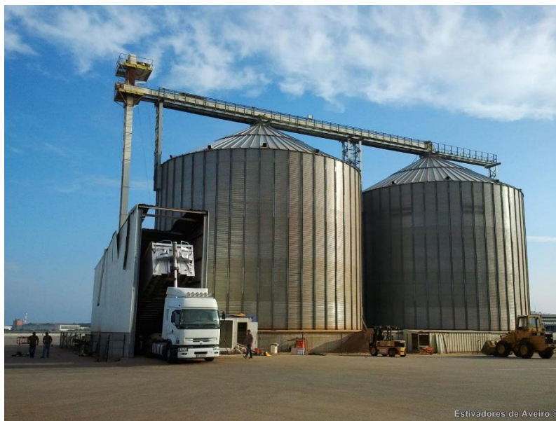
Figura 48 - Silos de armazenamento de pellets situados no Porto de Aveiro. (Fonte: (Aveiro, 2013))
