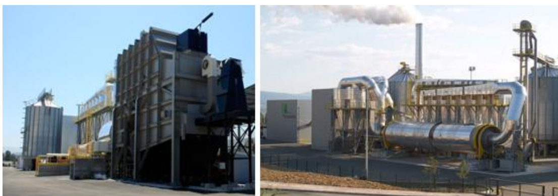
Figura 29 - Exemplo das instalações técnicas da operação de secagem, à esquerda a fornalha e à direita o secador rotativo, os ciclones e o silo de armazenamento (Fonte: (Enerpellets, 2013b; Pinewells, 2013))
