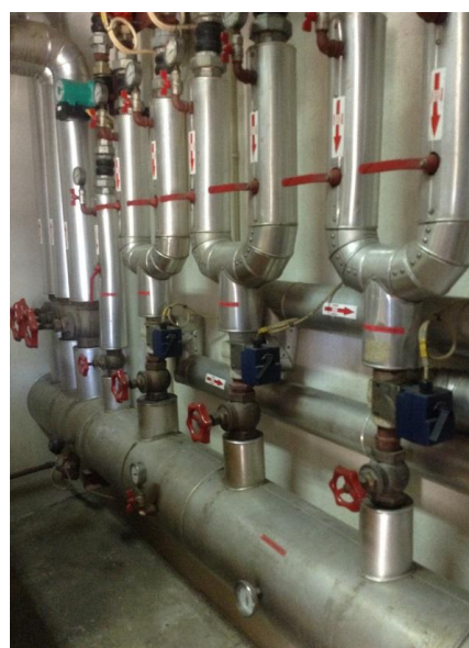
FIGURA 27 - COLETOR DE RETORNO DE AQS
