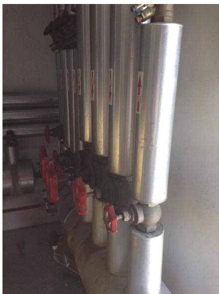
FIGURA 26 - COLETOR DE ENVIO DE AQS
