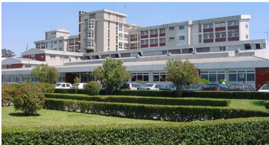
FIGURA 5 – BLOCO CENTRAL DO HOSPITAL INFANTE D. PEDRO. (FONTE: DIÁRIO DE AVEIRO)
