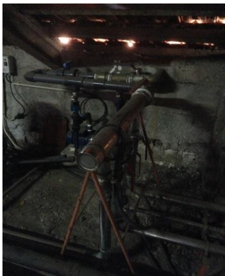
FIGURA 23 - COLETOR QUE ENVIA A ÁGUA PARA A REDE
