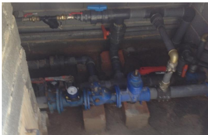
FIGURA 11 - DOIS RAMAIS DE ENTRADA DA ÁGUA (PRETO-GERAL; AZUL-INCÊNDIO).
