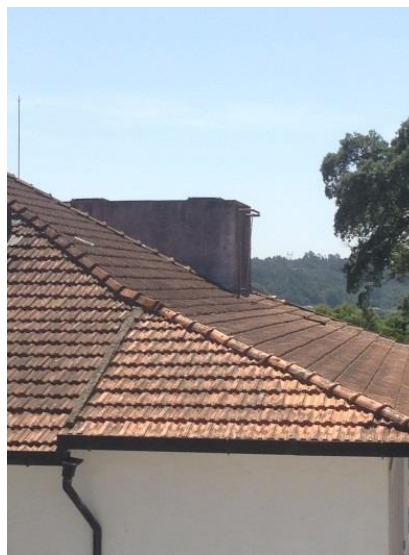
FIGURA 24 - DEPÓSITO DE ÁGUA
