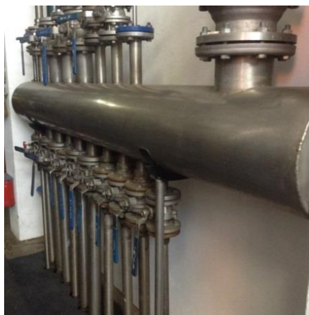
FIGURA 12 – COLETOR DE DISTRIBUIÇÃO DA ÁGUA PELOS DIFERENTES SERVIÇOS.
