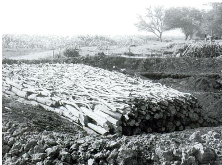
Figura 2.3 - Primeiro forno de queima de carvão vegetal, Pit Kiln .
