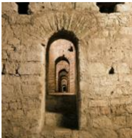
Figura 28. Celas das galerias do piso superior do Criptopórtico, Museu Nacional Machado de Castro. 103
