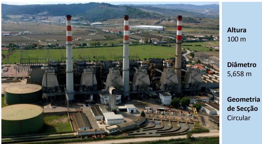
Figura 3.8 – Fontes de emissão de poluentes da central termoeletrica do Carregado e suas características geométricas
