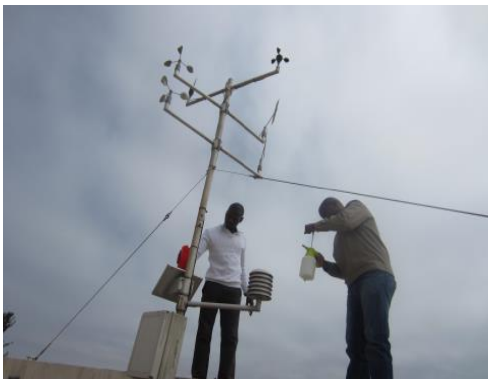
Figura 3_ Estação de Meteorologia automática (EMA) CIP/Nbe
