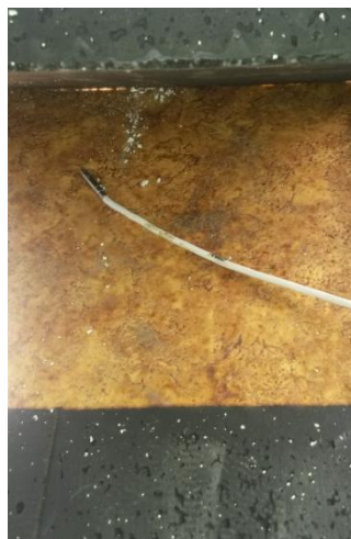
Fig. 22. Sondas PT100 a realizar monitorização de temperatura inferior.
