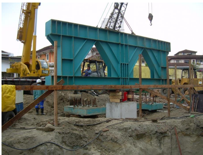
[2] Instalação do sistema de medição do ensaio de carga (fonte: GEO, 2010 [3:16]).
