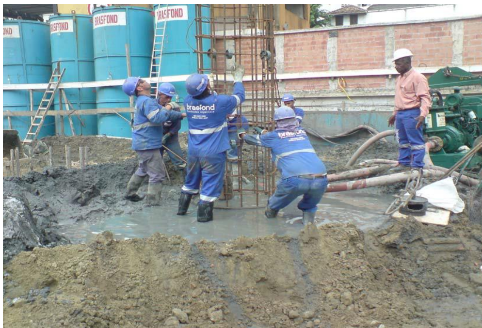
[6] Colocação da armadura (fonte: BRASFOND, 2010 [3:15]).
