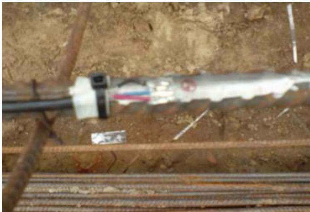
[5] Instalação dos extensómetros eléctricos na armadura (fonte: BRASFOND, 2010 [3:15]).
