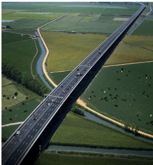
[1] Travessia no Rio Tejo no Carregado (fonte: Brisa [3:1]).
