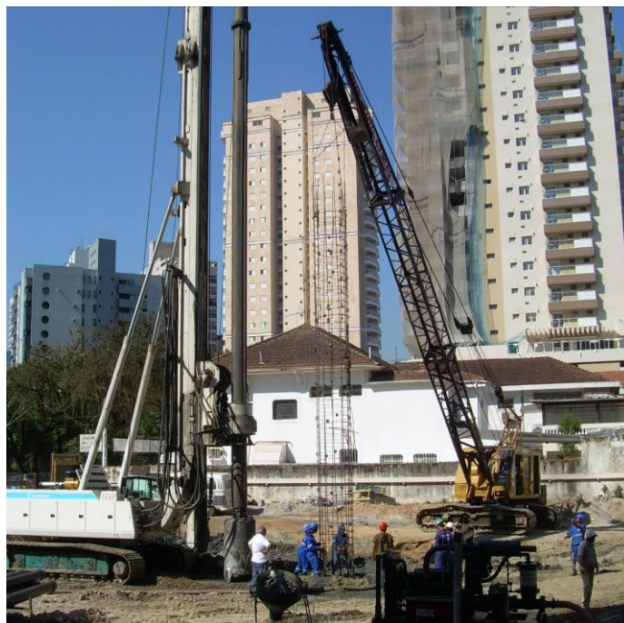
[1] Colocação da armadura (fonte: GEO, 2010 [3:16]).
