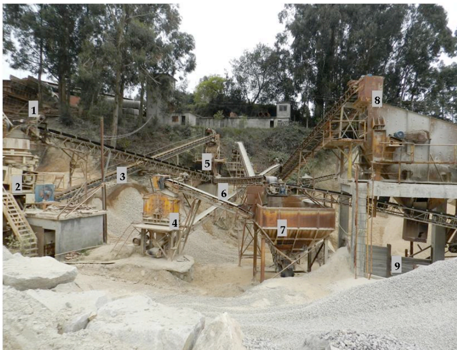
Figura 38: Fotografia das instalações de fragmentação da Pedreira Sacramento, Oliveira de Azeméis (imagem de Bruno Soares). Legenda: 1) Torva e fragmentador de maxilas; 2) Granulador primário; 3) Tela transportadora; 4) Moinho de martelos (impacto); 5) Crivo; 6) Granulador secundário; 7) Torva; 8) Crivo; 9) Produto final armazenado em lotes.
