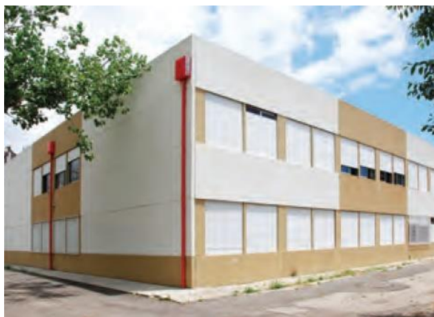
Figura 11 – Pavilhão de salas de aula do Projeto “3 X 3” (Proença e Gago, 2011).
