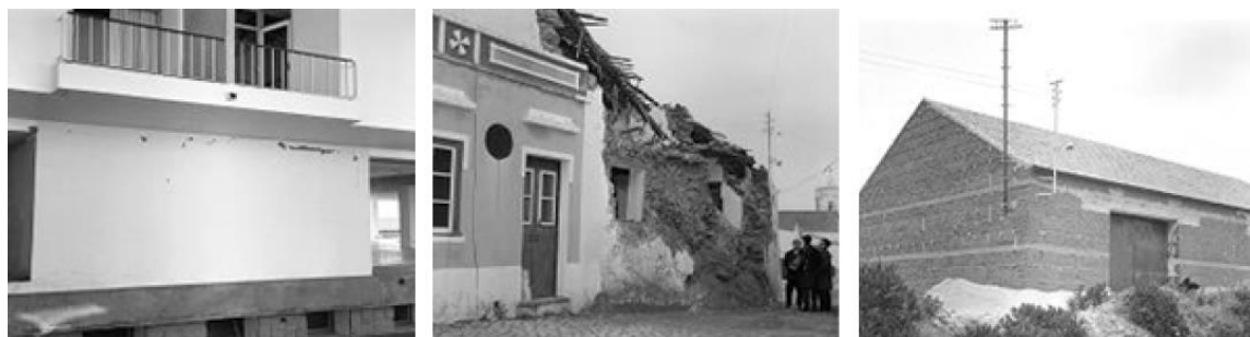
Figura 13 – Danos em edifícios na região mais afetada pelo sismo de 1969 (Marecos e Castanheta, 1970).
