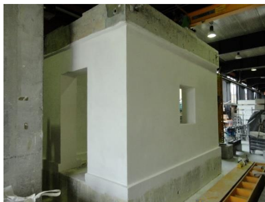
Figura 3.19 - Estado da estrutura após a conclusão do reforço.
