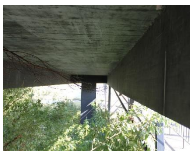
Figura 6.8 - Pormenor do pilar de apoio à rampa situada a Sul.
