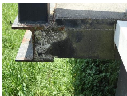
Figura 6.3 - Pormenor do perfil metálico localizado na lateral da laje de betão.
