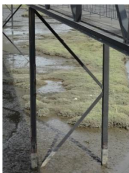
Figura 6.6 - Pormenor dos pilares de apoio.
