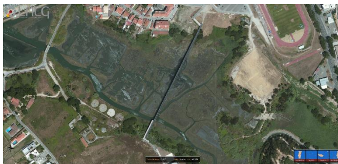
Figura 6.2 - Imagem satélite da localização da ponte pedonal da UA (LNEG, 2010).
