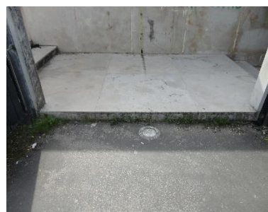
Figura 6.12 - Vista da entrega do tabuleiro a Sul.
