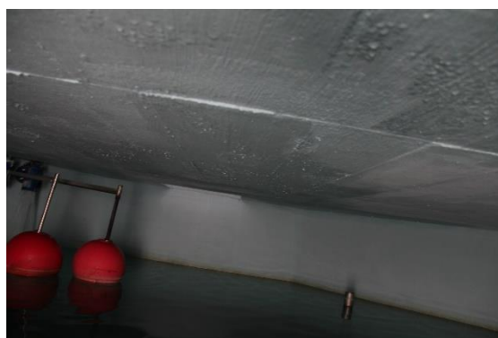
Figura 5.8 - Ilustração do interior do reservatório, sendo visível o teto, em betão armado, do interior do reservatório.
