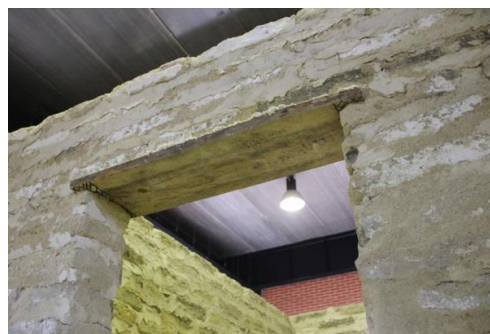
Figura 3.3 - Pormenor construtivo da padieira.
