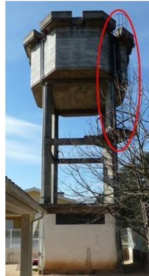
Figura 5.5 - Ilustração da escada metálica de acesso ao topo do depósito de água.
