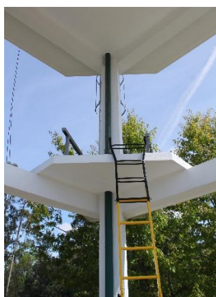
Figura 5.9 - Ilustração das vigas, pilares e laje de acesso.
