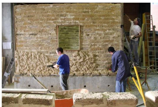
Figura 3.5 - Aplicação do reboco no modelo.
