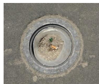
Figura 6.5 - Pormenor de um dos focos luminosos da ponte pedonal.
