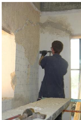
Figura 3.13 - Remoção do reboco da estrutura.
