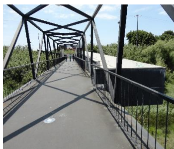
Figura 6.7 - Vista da rampa a Sul da ponte pedonal da UA.
