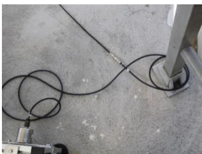
Figura 5.17 - Pormenor da ligação de um cabo extensómetro.
