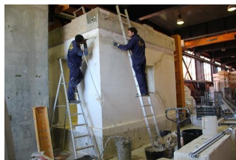
Figura 3.12 - Injeção de caldas nas fissuras da estrutura.
