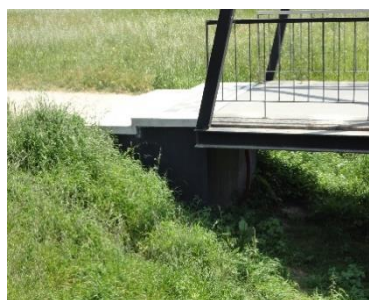
Figura 6.10 - Vista geral da entrega do tabuleiro a Norte.
