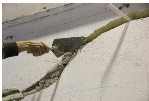
Figura 3.11 - Colocação de argamassa nas fissuras da estrutura.
