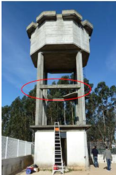
Figura 5.4 - Indicação das vigas de contraventamento.
