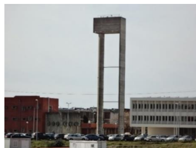
Figura 4.2 - Perfil do depósito de água da UA.
