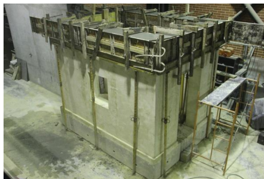
Figura 3.7 - Construção da viga de betão armado.
