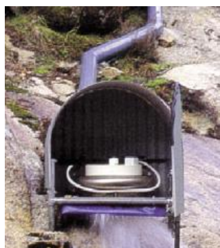
Figura 2.26 – Micro-hidrogerador instalado numa nascente [9]
