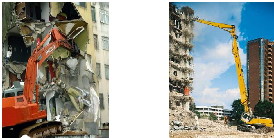
Figura 2.41 – Processos de demolição seletiva
