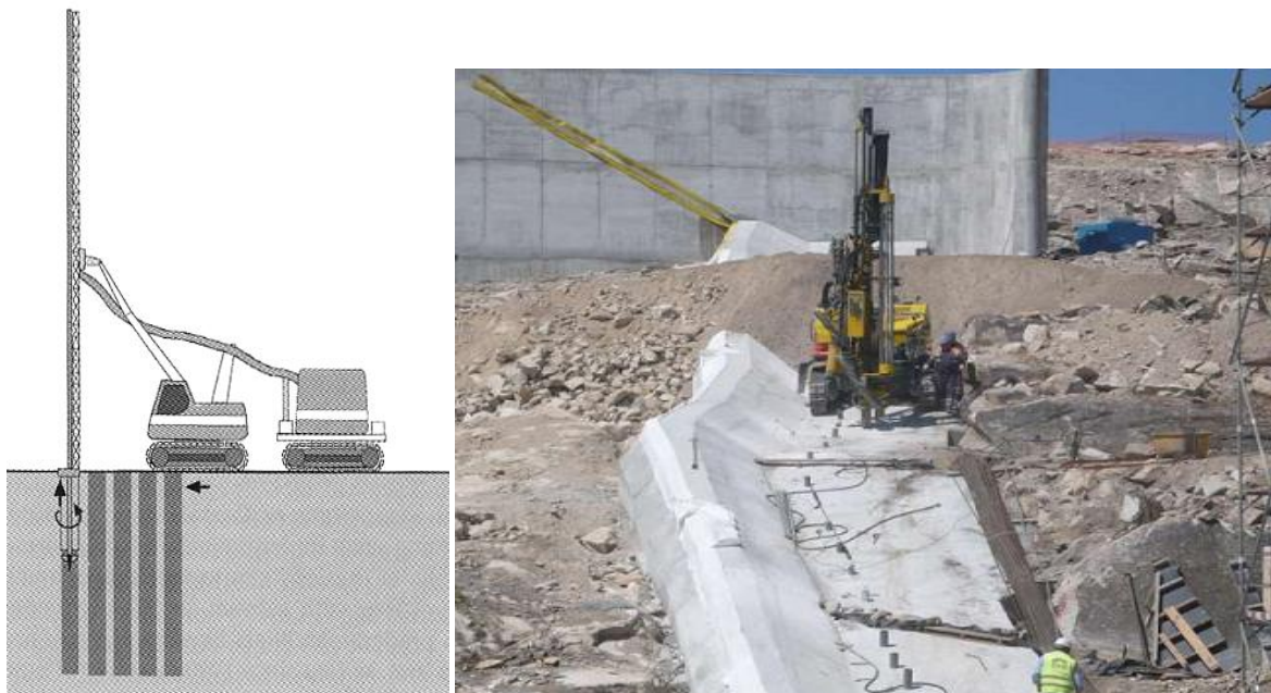
Figura 2.6- Execução da Técnica Injeções (Mota-Engil 2012)
