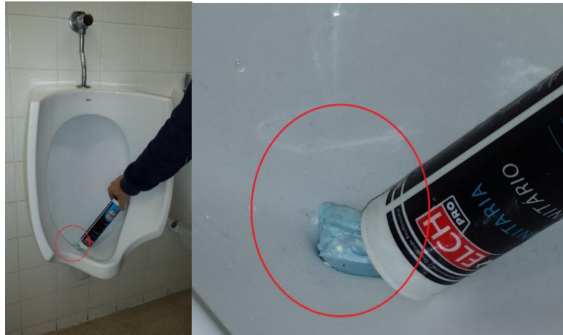
Figura 22 - Tamponamento do urinol
