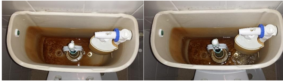
Figura 18 - Início do enchimento
