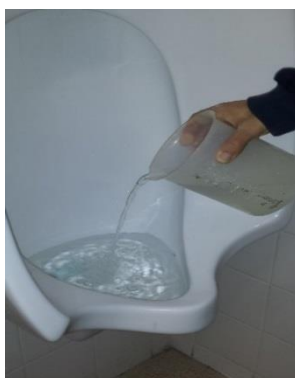
Figura 24 - Colocação de água na bacia do urinol
