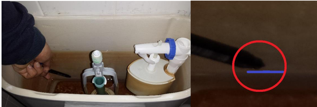
Figura 20 - Marcação da cota mínima do autoclismo
