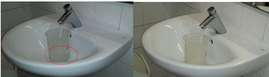
Figura 16- Medição dos volumes nos lavatórios
