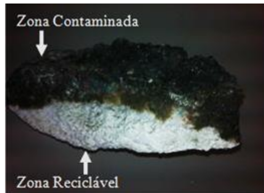
Figura 5: fotografia de um pedaço de revestimento abatido, onde se distinguem a zona contaminada e a zona reciclável.
