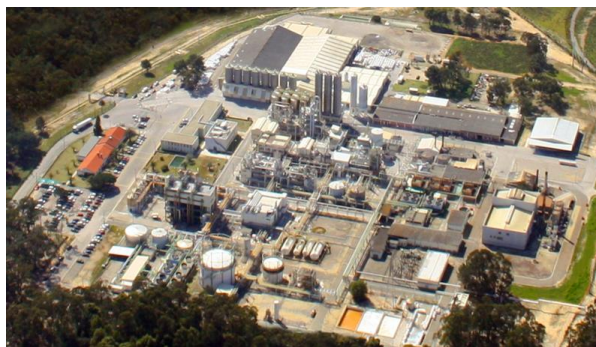
Figura 1.4: Vista aérea da área fabril da CIRES. [8]
