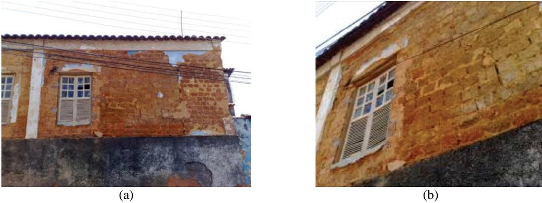
Figura 64: (a) e (b) Alvenarias em adobe. Fotos Margareth Figueiredo.
