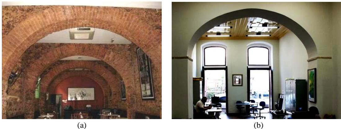
Figura 62: (a) Arcos estruturais (em tijoleira) no pavimento térreo; (b) Ambientes interligados por arco estrutural. Fotos Margareth Figueiredo.
