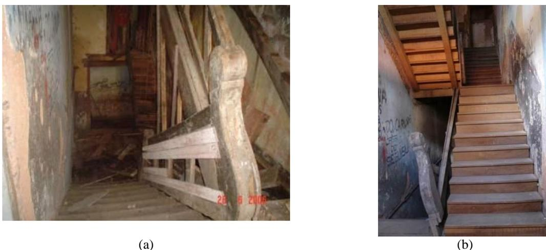
Figura 99: (a) Condição precária da escada de madeira de um corredor central; (b) Estrutura da escada madeira de um corredor central com peças novas. Fonte: Arquivo do IPHAN/3ª SR.
