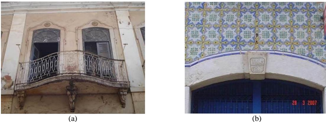
Figura 81: (a) Detalhe dos ornamentos em lioz na moldura de esquadrias e balcão em lioz apoiado em mísulas; (b) Verga em lioz, e chave de arco com inscrições de data de construção e letras iniciais do nome do proprietário. Fotos Margareth Figueiredo.
