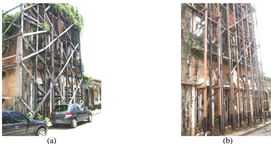
Figura 105: (a) Imóvel em ruínas à Rua do Giz, s/n, com escoramento em madeira; (b) Substituição de peças de madeira do escoramento do imóvel à Rua do Giz, s/n. Fonte: IPHAN/3ª SR.
