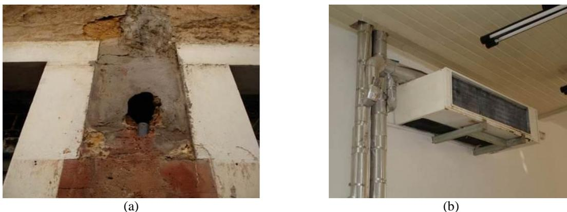
Figura 82: (a) Tubulação elétrica embutida em parede; (b) Instalação aparente de ar-condicionado. Fotos: Margareth Figueiredo.
