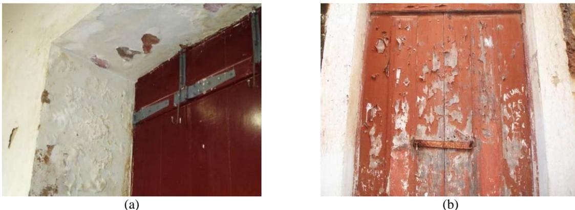
Figura 80: (a) e (b) bolhas e escamações originadas por material de pintura incompatível. Fotos Margareth Figueiredo.
