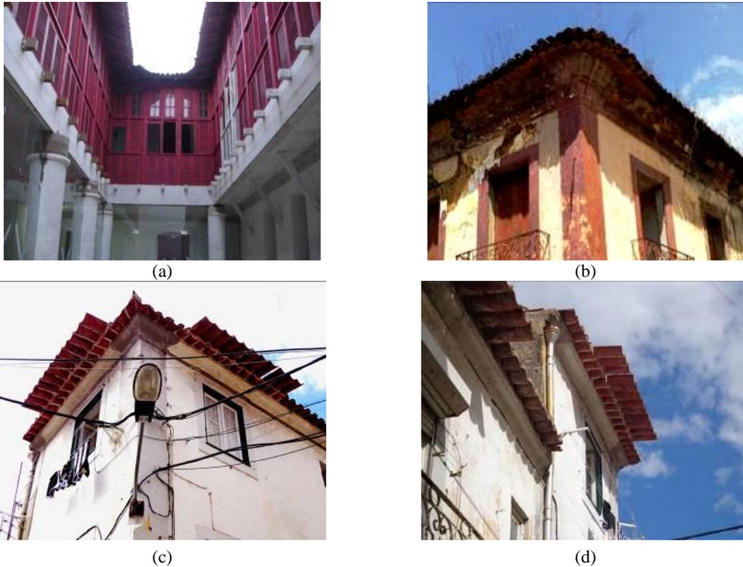
Figura 3: (a) Varanda posterior com fechamento em veneziana, madeira e vidro; (b) Beiral (em São Luís) com sobreposição de duas telhas; (c) e (d) Edificações em Setúbal (Portugal) apresentando beiral com sobreposição de duas telhas. Fotos: (a), (b), (c) e (d) Margareth Figueiredo.
