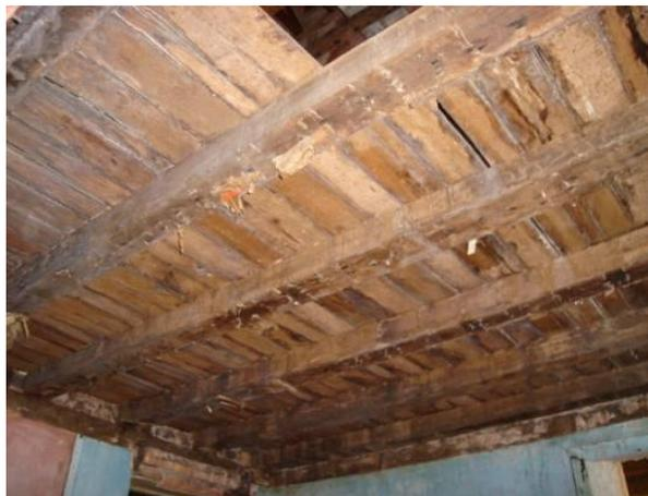
Figura 65: Detalhe da estrutura dos barrotes com assoalho. Fonte: Acervo do IPHAN/3ª SR.
