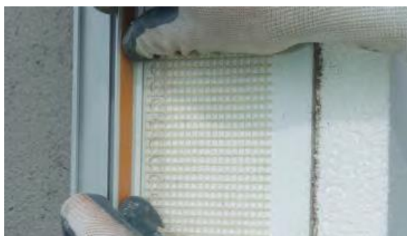
Figura 76. Perfil de janela (Fonte: Weber, 2013)
