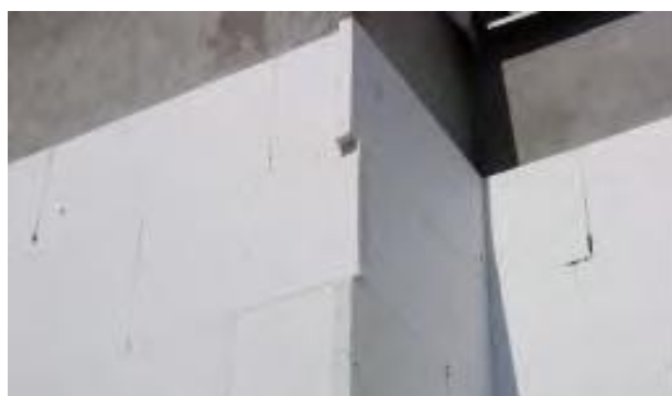
Figura 34. Travamento do sistema de isolamento (Fonte: Weber, 2013)
