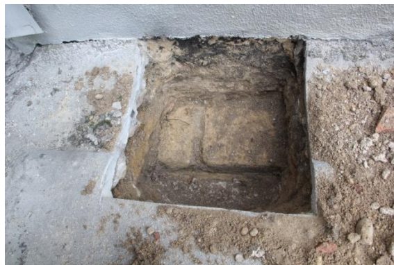
Ilustração 31 - Poço de inspeção 3 – Fotografia 4 na Ilustração 27
