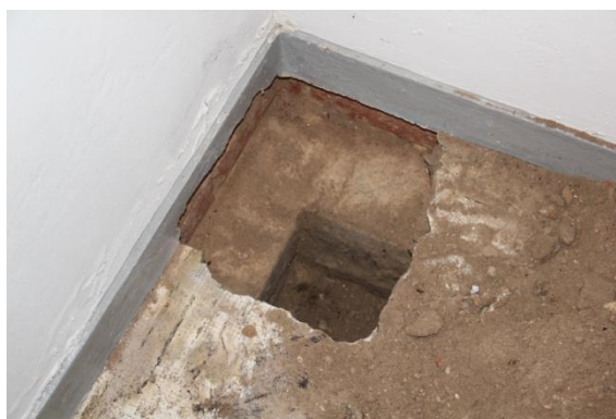
Ilustração 39 - Poço de inspeção 10 – Fotografia 12 na Ilustração 27
