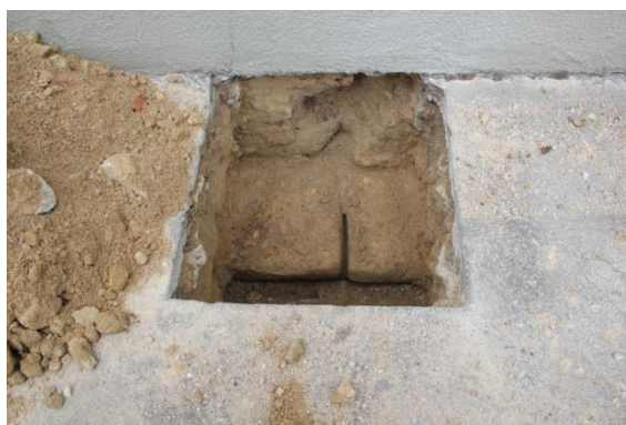
Ilustração 29 - Poço de inspeção 1 – Fotografia 2 na Ilustração 27
