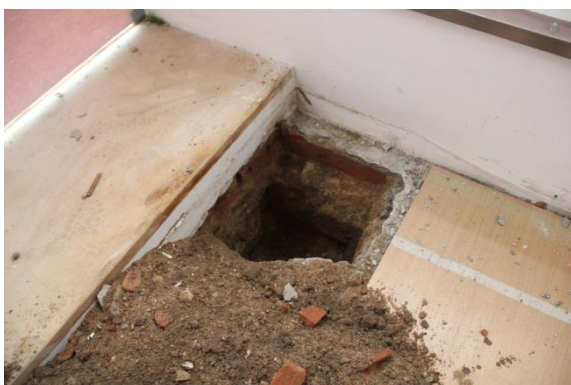
Ilustração 34 - Poço de inspeção 5 – Fotografia 7 na Ilustração 27
