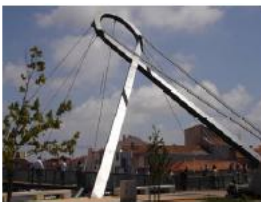
Ilustração 2 - Vista geral da ponte (Barbosa et al. , 2008)
