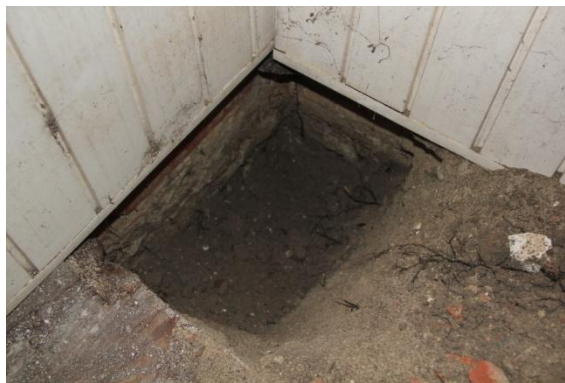
Ilustração 37 - Poço de inspeção 8 – Fotografia 10 na Ilustração 27
