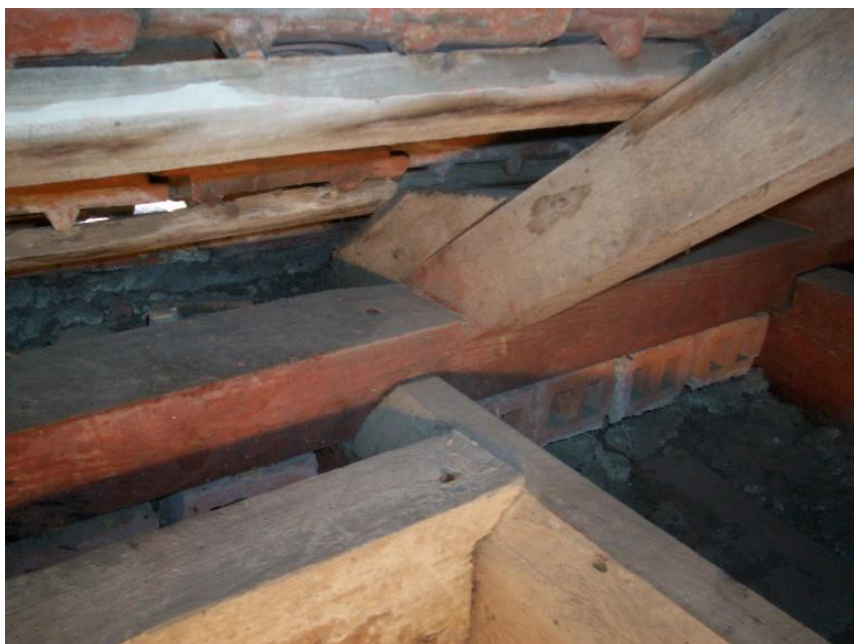
Ilustração 80 - Ligação “dente posterior” entre barrote de cobertura e frechal
