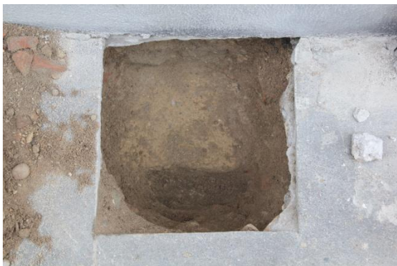
Ilustração 30 - Poço de inspeção 2 – Fotografia 3 na Ilustração 27
