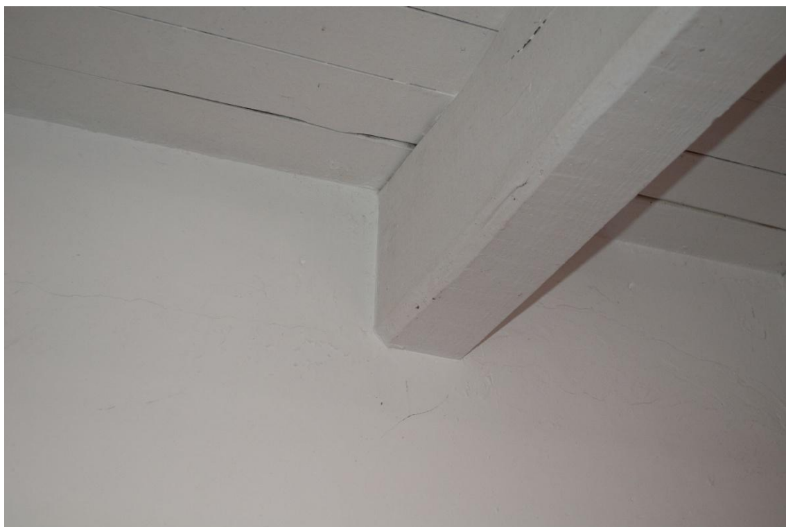
Ilustração 53 – Entrega de uma viga numa parede interior do piso térreo
