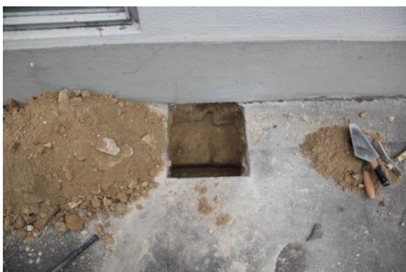
Ilustração 28 - Poço de inspeção 1 – Fotografia 1 na Ilustração 27
