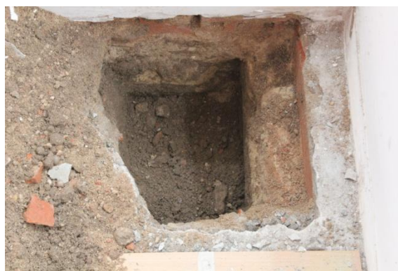
Ilustração 33 - Poço de inspeção 5 – Fotografia 6 na Ilustração 27
