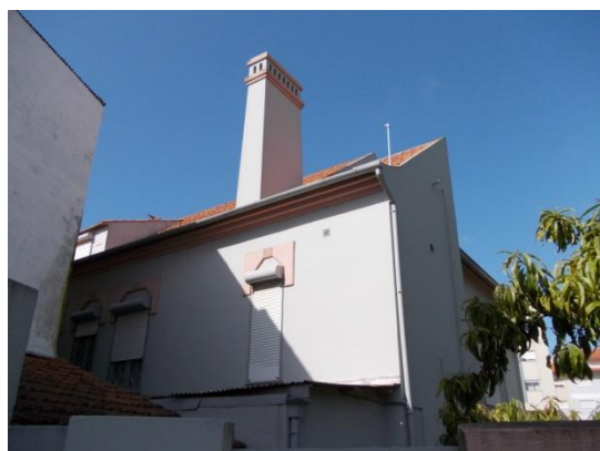
Ilustração 18 – Fachada lateral direita
