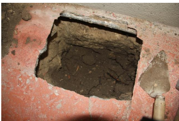
Ilustração 32 - Poço de inspeção 4 – Fotografia 5 na Ilustração 27
