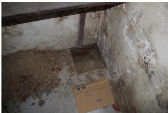
Ilustração 36 - Poço de inspeção 7 – Fotografia 9 na Ilustração 27
