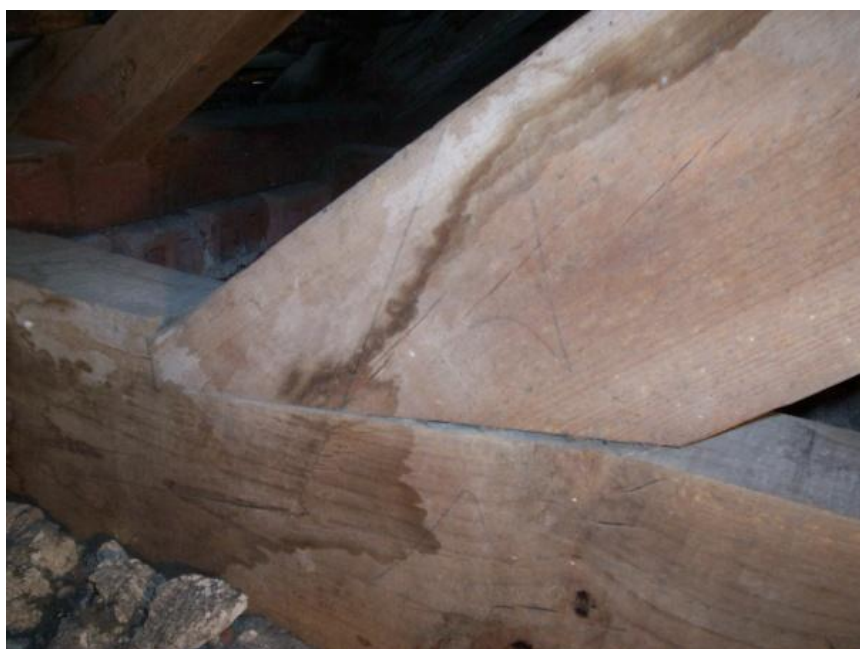
Ilustração 73 - Ligação "dente anterior" entre asna e viga
