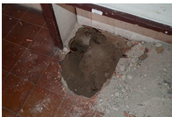
Ilustração 41 - Poço de inspeção 11 – Fotografia 14 na Ilustração 27
