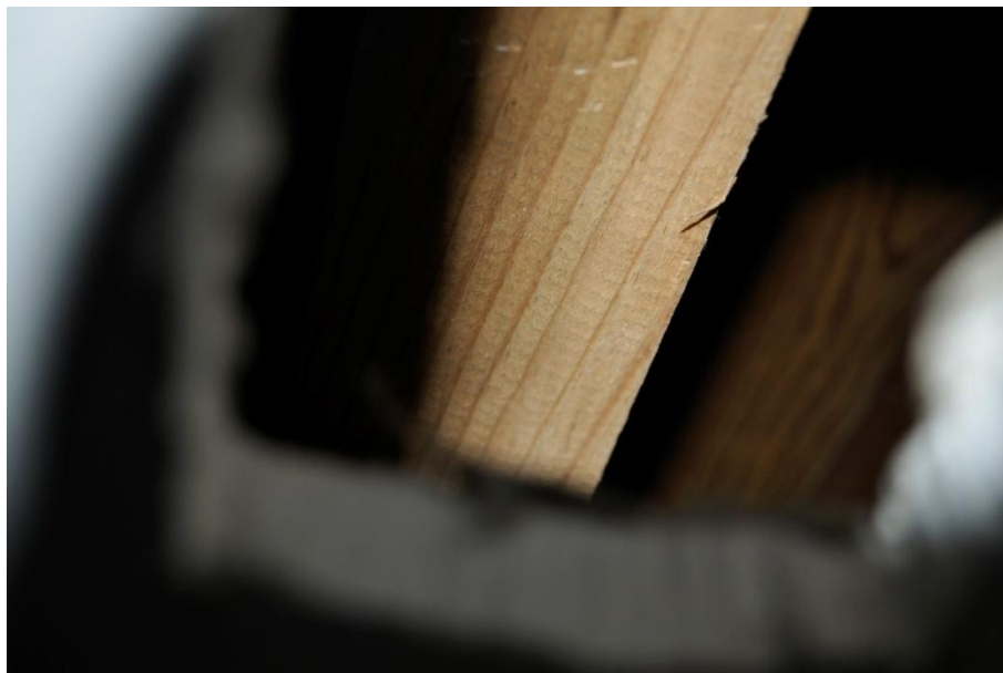
Ilustração 61 - Tarugo do pavimento do Piso 1
