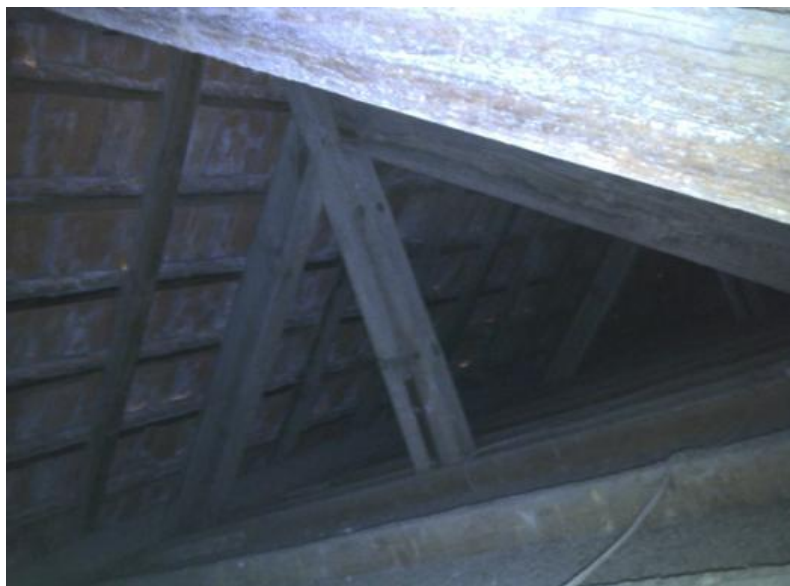
Ilustração 74 - Vista geral da asna de cobertura
