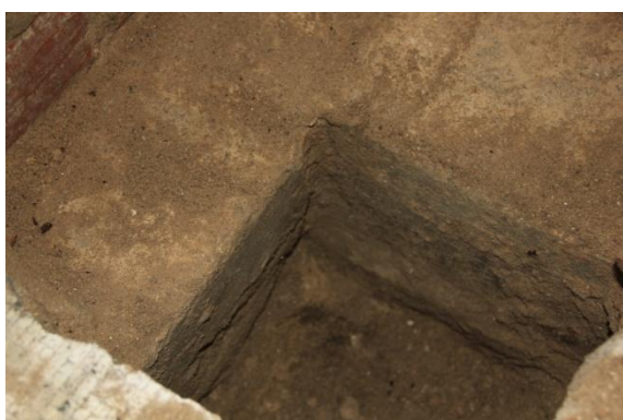
Ilustração 40 - Poço de inspeção 10 – Fotografia 13 na Ilustração 27
