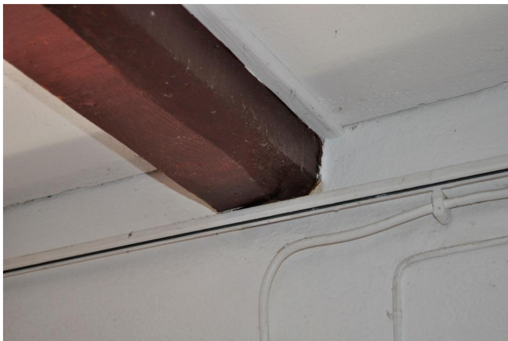
Ilustração 54 - Entrega de uma viga de piso na parede de fachada
