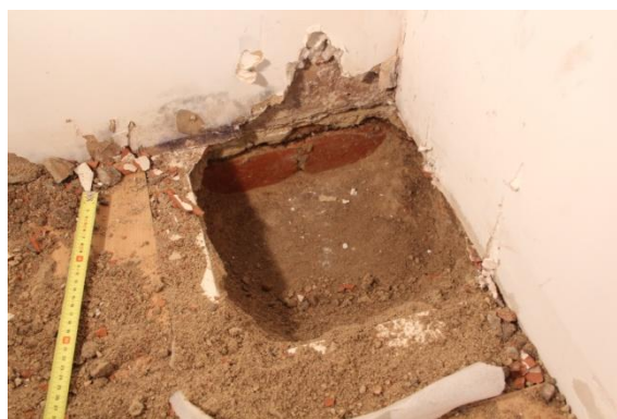
Ilustração 35 - Poço de inspeção 6 – Fotografia 8 na Ilustração 27
