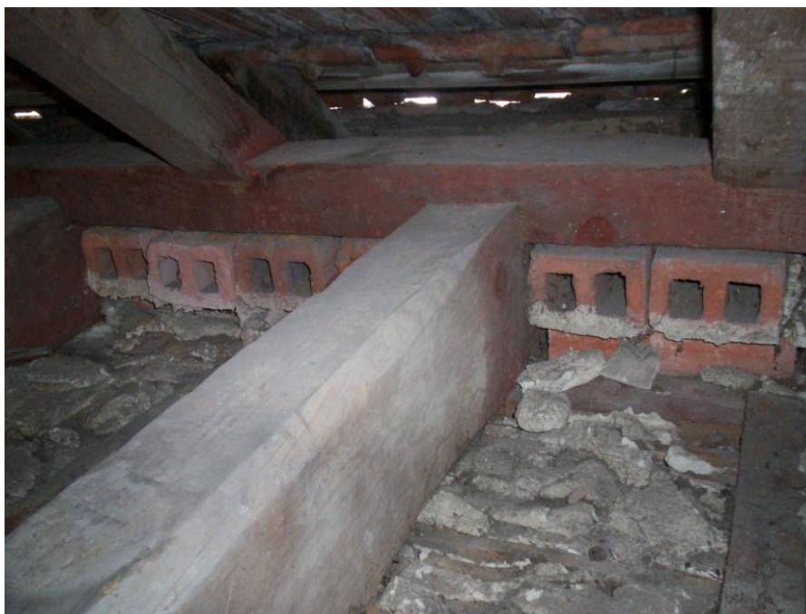
Ilustração 55 - Entrega de uma viga de cobertura na parede de fachada
