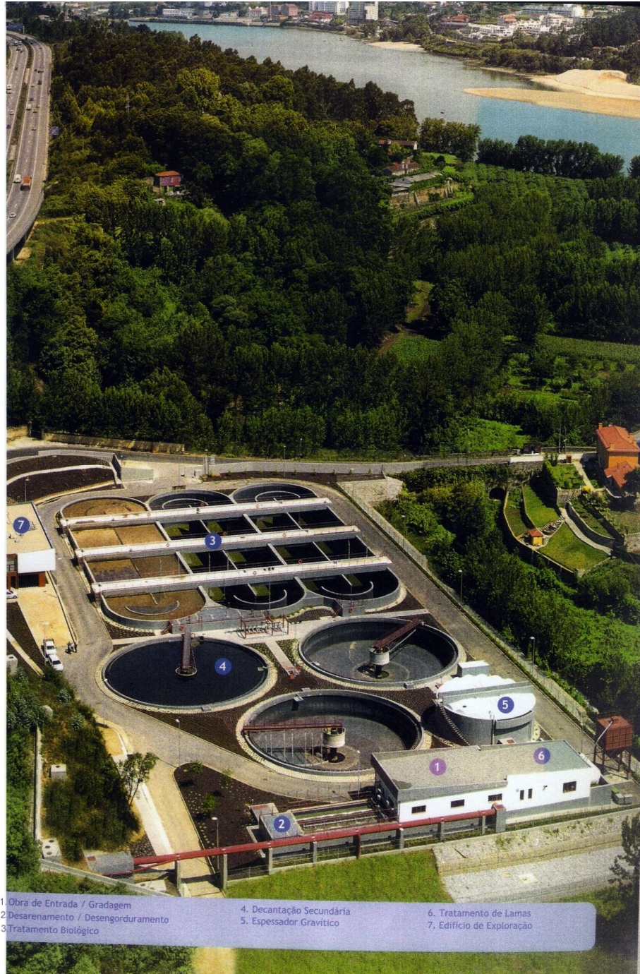
Figura 4: Vista da ETAR de Febros com detalhe da distribuição espacial dos diferentes órgãos de tratamento (adaptado de [11])
