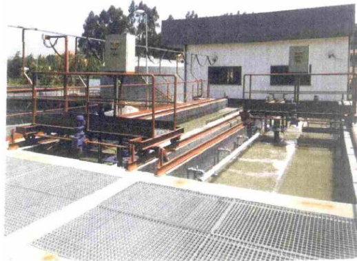
Figura 6: Zona de desarenamento e desengorduramento da ETAR (adaptado de [11])
