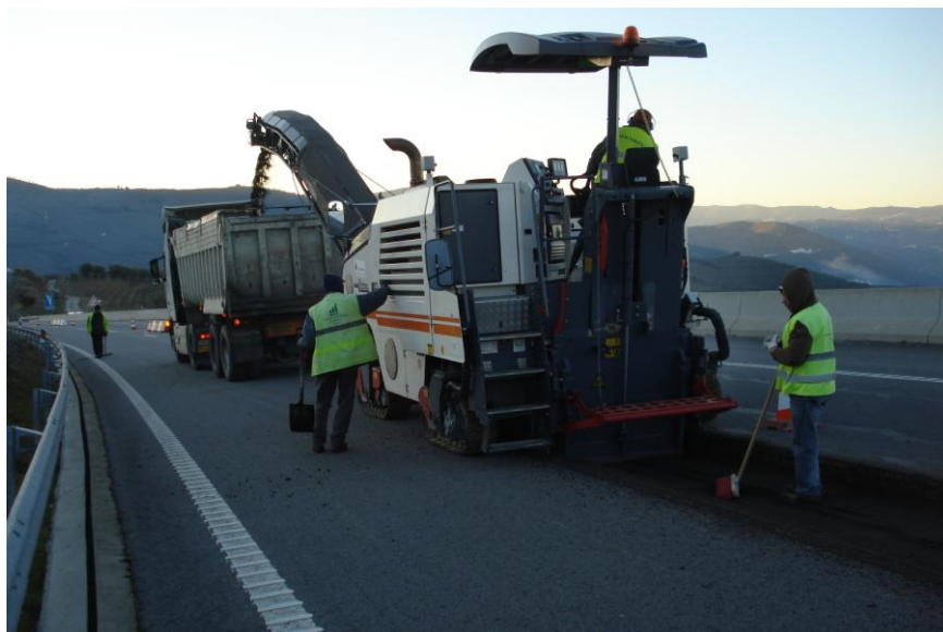
Figura 5.2 - Recolha de resíduos betuminosos - fresagem (Francisco Pereira Marinho & Irmãos, S.A., 2007)
