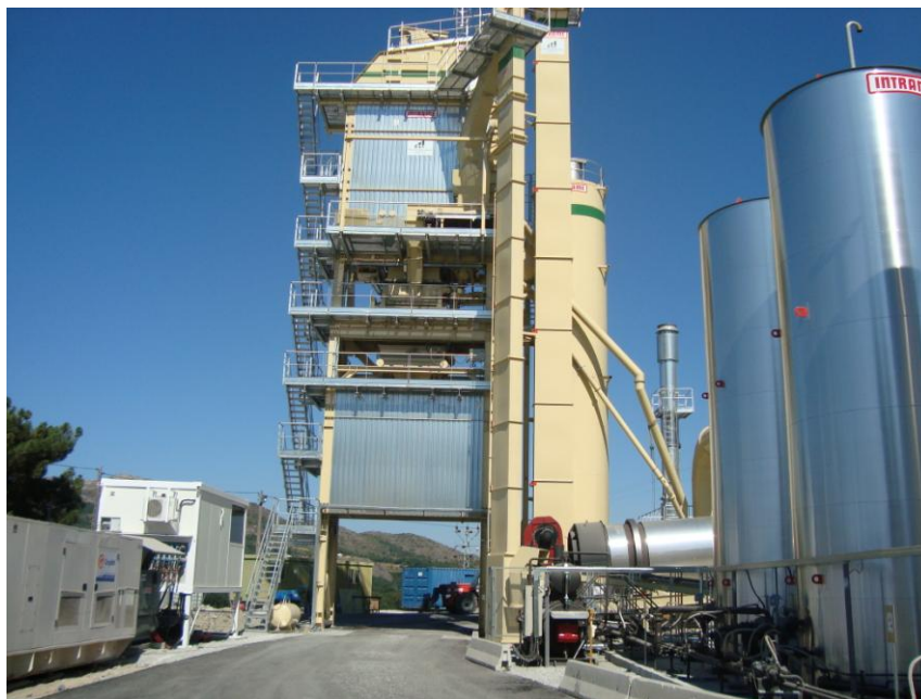
Figura 5.3 - Vista geral da Central de Betuminosos de Monteiras (Francisco Pereira Marinho & Irmãos, S.A., 2010)
