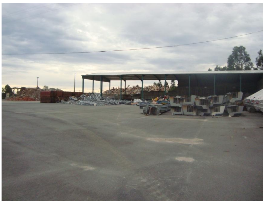
Figura 3.1 - Vista geral da RESIMAR (Francisco Pereira Marinho & Irmãos, S.A., 2009)
