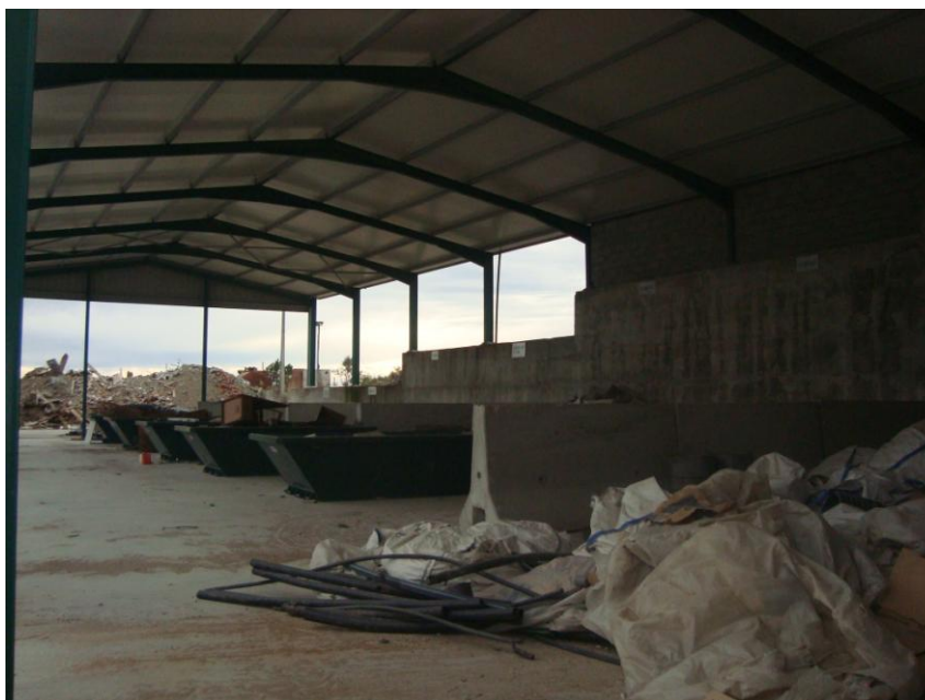
Figura 4.3 - Vista da área coberta onde é feita a separação inicial dos resíduos (Francisco Pereira Marinho & Irmãos, S.A., 2009)
