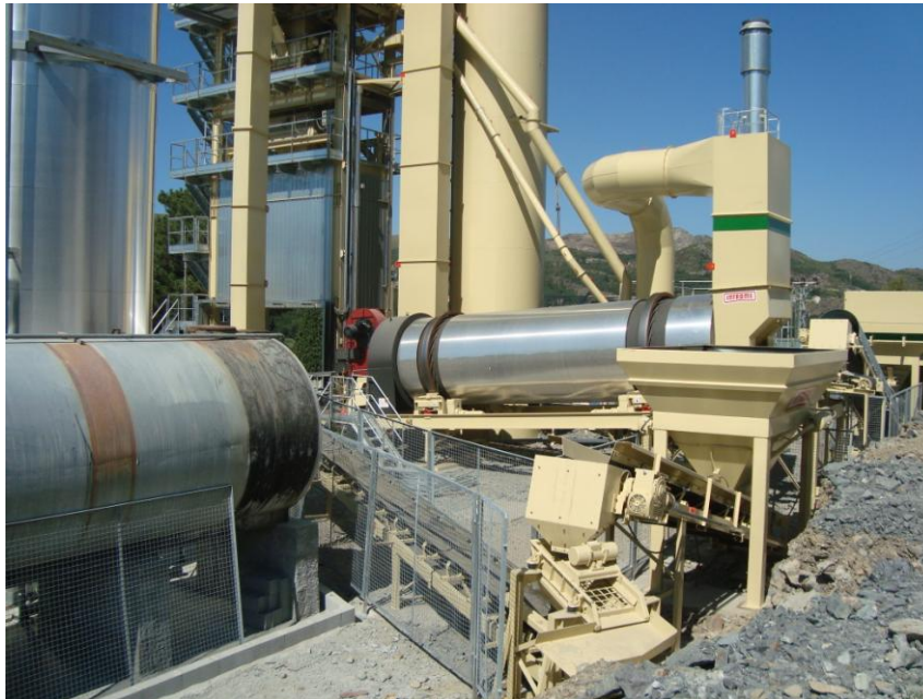
Figura 5.5 - Tolva e tela transportadora de resíduos betuminosos (Francisco Pereira Marinho & Irmãos, S.A., 2010)
