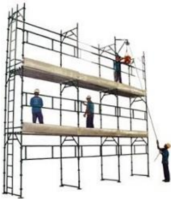
Figura 42: Andaimes com proteção 1 .
