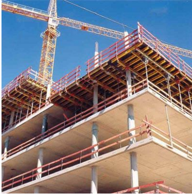
Figura 44: Exemplo de trabalhos em altura com guarda-corpos 3 .
