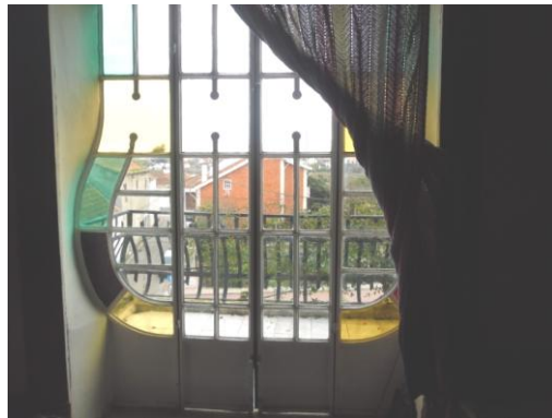
c) Porta da fachada principal do sótão
