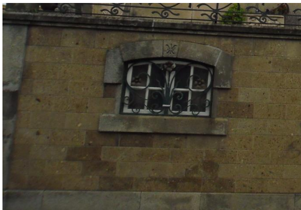
a) Janela de abrir para dentro de eixo vertical com grades
