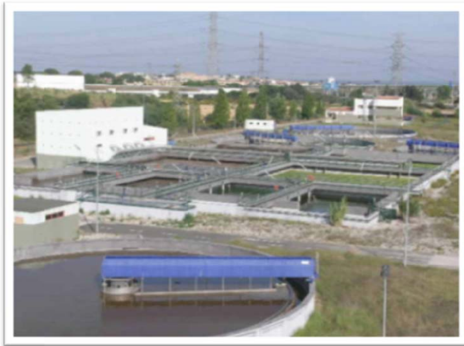
Figura 24 – ETAR de Setúbal (Fonte: Águas do Sado)
