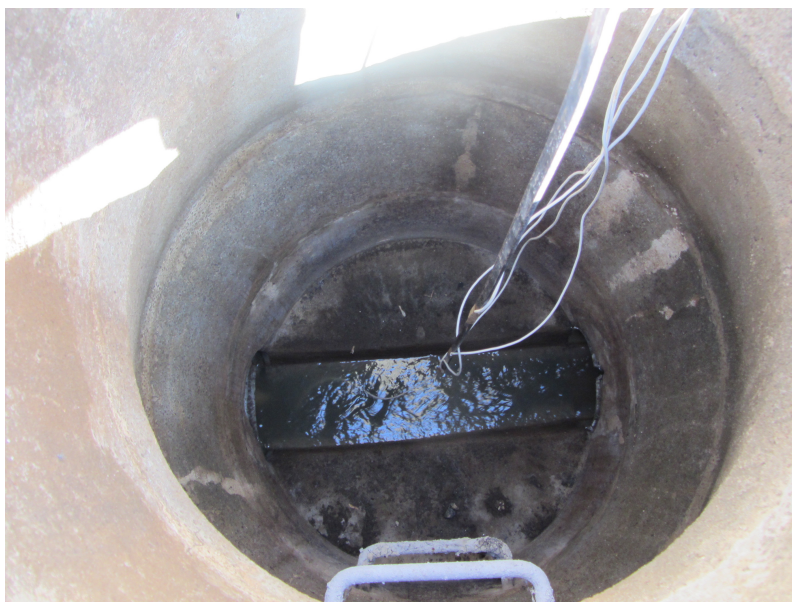
Figura 42 - Colocação dos termopares na câmara de visita.
