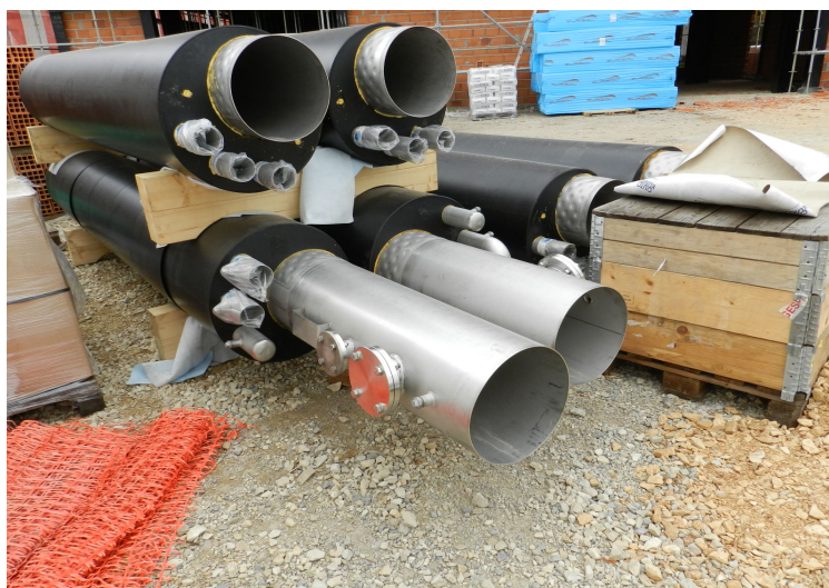
Figura 19 - Coletor sob pressão com permutador.
