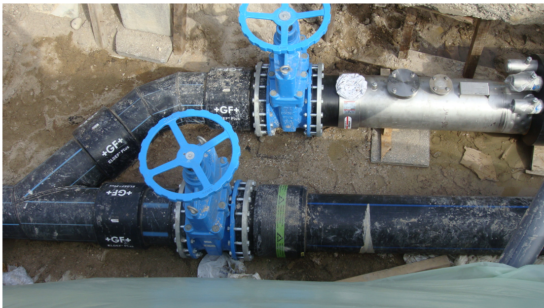
Figura 60 - Zona de derivação entre a conduta que substitui a existente e o permutador, onde é construída a câmara de manobra e operação. A azul, as válvulas de corte.
