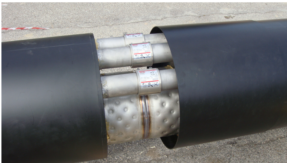
Figura 59 - Pormenor das ligações entre os módulos
