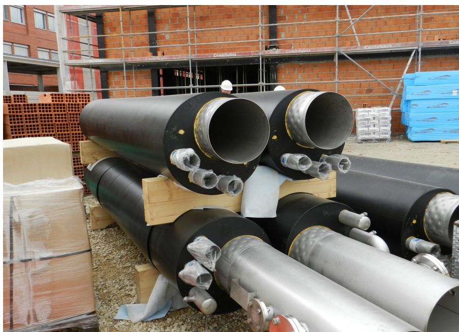
Figura 58 - Alguns dos módulos do permutador.
