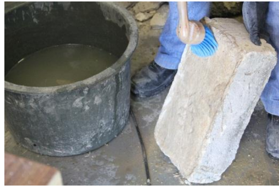
b) Molhagem prévia da superfície do bloco
