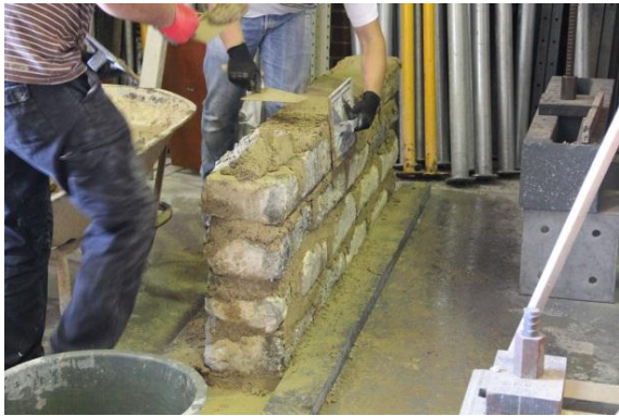
a) Construção da 4ª fiada de alvenaria de adobe
