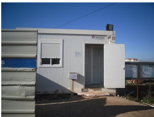
Figura 32. Controlo das entradas e saídas no estaleiro
