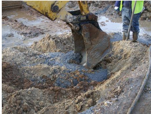
Figura 16. Remoção de detritos na cabeça da estaca
