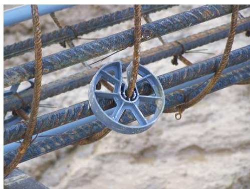
Figura 18. Armadura com os espaçadores
