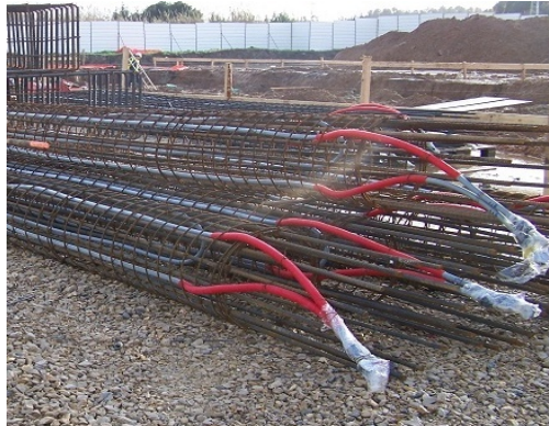
Figura 53. Armaduras dotadas de tubo PE-Xa
