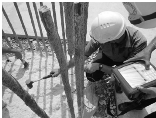
Figura 27. Aplicação de pancada com martelo na cabeça da estaca
