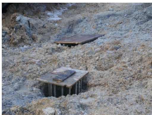
Figura 42. Painel de contraplacado marítimo na cabeça da estaca
