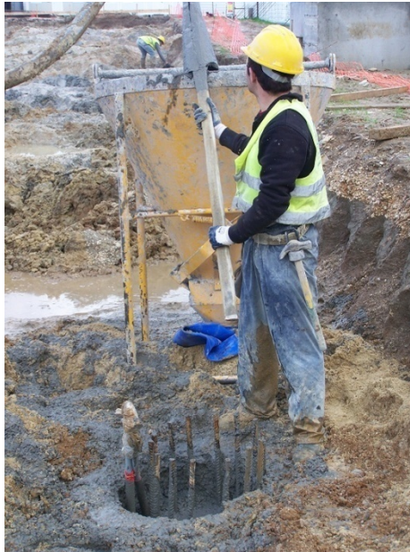
Figura 26. Recolha para aproveitamento em betão de limpeza
