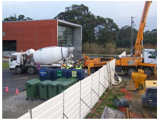
Figura 13. Equipamentos de fornecimento e de bombagem do betão
