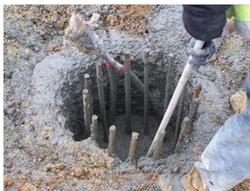
Figura 25. Remoção de betão em excesso
