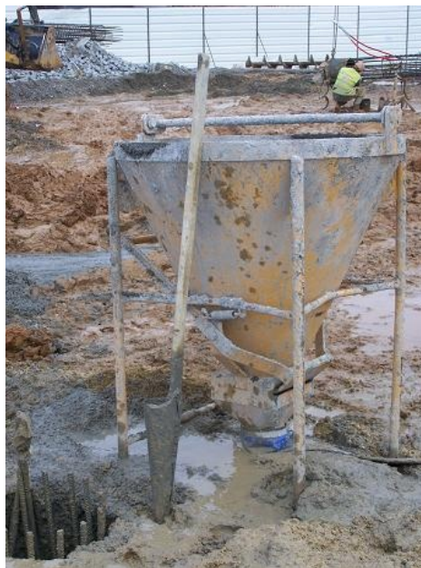
Figura 24. Ferramenta manual de recolha de betão
