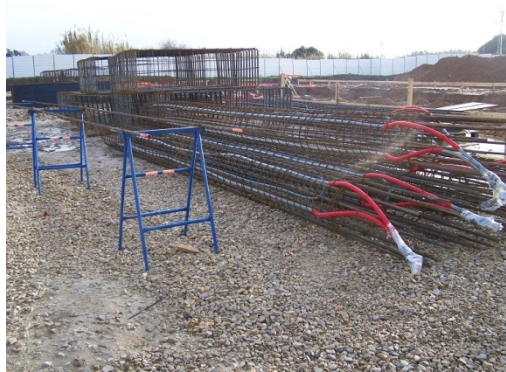
Figura 40. Local de montagem e armazenamento das armaduras das estacas
