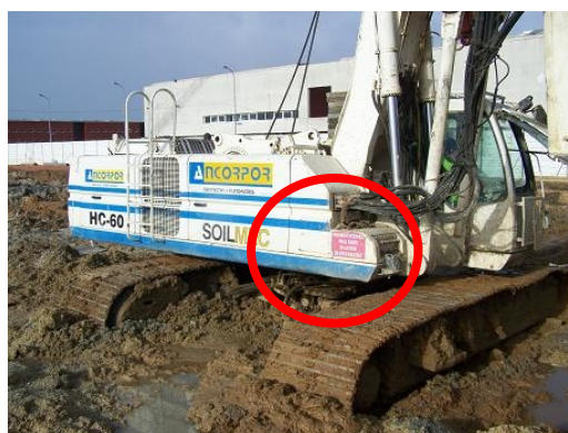
Figura 36. Sinalização de segurança
