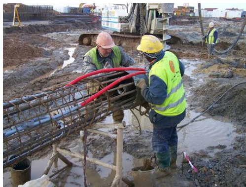
Figura 17. Introdução do vibro-punçor na cabeça da estaca
