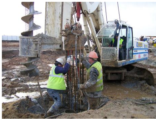
Figura 22. Introdução da armadura na estaca
