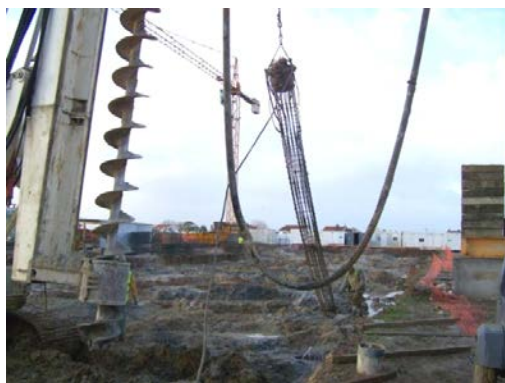
Figura 20. Elevação da armadura recorrendo ao equipamento de furação
