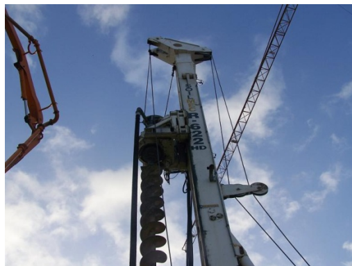
Figura 14. Pormenor do ponto de entrada do betão no topo do trado
