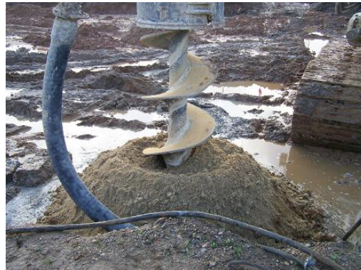
Figura 12. Início da furação do terreno
