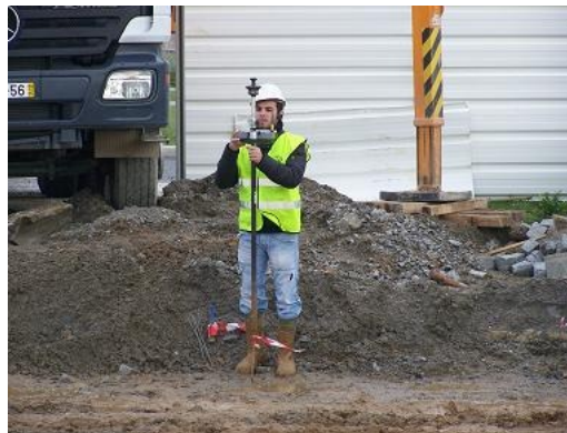
Figura 9. Implantação das estacas com recurso a serviços de topografia
