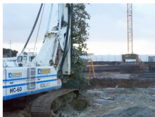
Figura 39. Remoção das terras do trado
