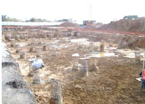
Figura 23. Estacas saneadas
