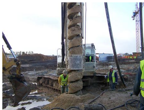
Figura 15. Remoção do trado
