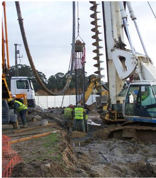
Figura 21. Verticalização e introdução da armadura no interior da estaca
