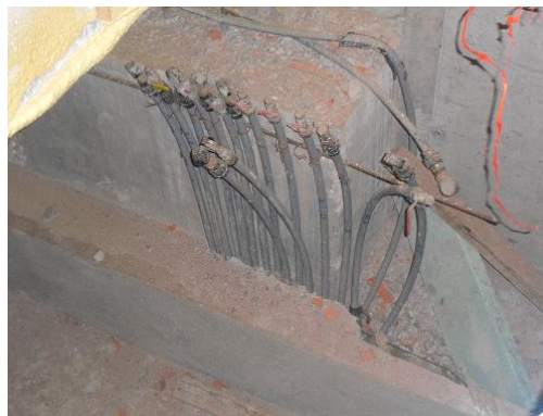
Figura 54. Ponto de chegada da tubagem
