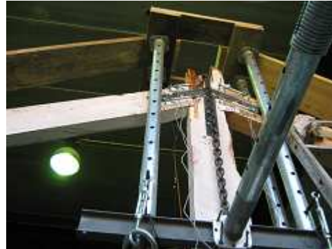
Figura 47 – Ligação superior pendural-perna.
