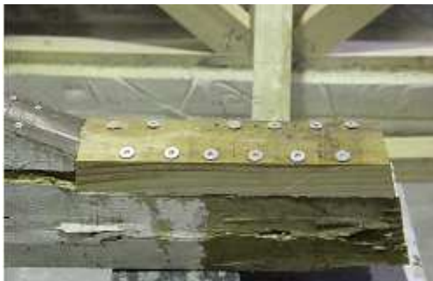
Figura 27 - Reforço ligação perna-linha.
