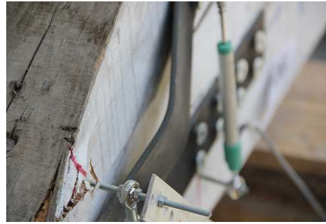
Figura 61 - Plastificação da chapa metálica.
