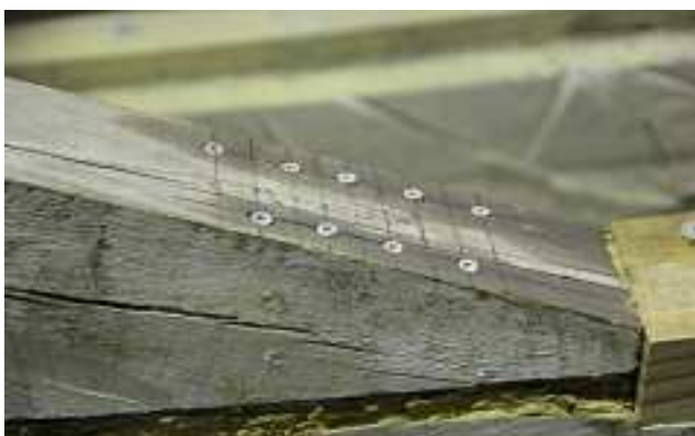
Figura 28 - Ligação perna-linha aparafusada (ligação 1 e 12).
