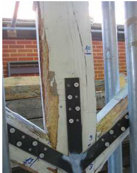
Figura 48 - Ligação inferior pendural-escora.
