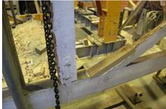
Figura 30 - Reabilitação efetuada escora e pendural (Ligação 5 e 8).
