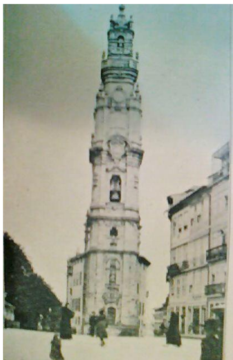
Figura 8 - Torre dos Clérigos
