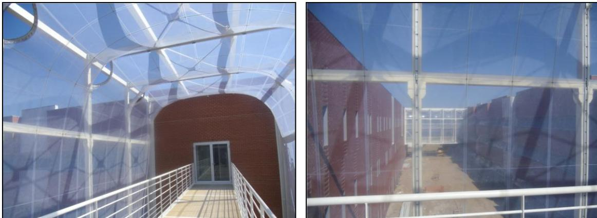
**Figuras 72 e 73-** Cobertura dos passadiços da ESSUA em ETFE.
