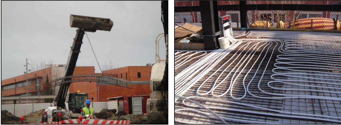
Figuras 29 e 30- Tubagem do sistema de geotermia.
