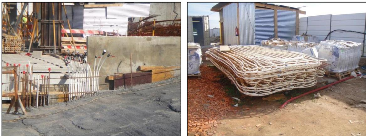
**Figuras 25 e 26-** Tubagem do sistema de geotermia.
