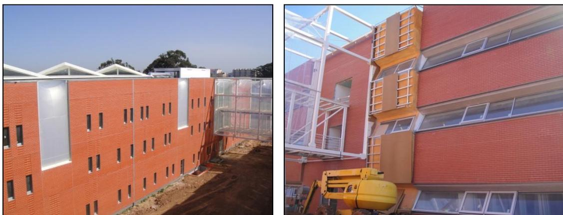
Figuras 32 e 33- Revestimento de tijolo face à vista tipo “Vale da Gândara” no edifício da ESSUA.
