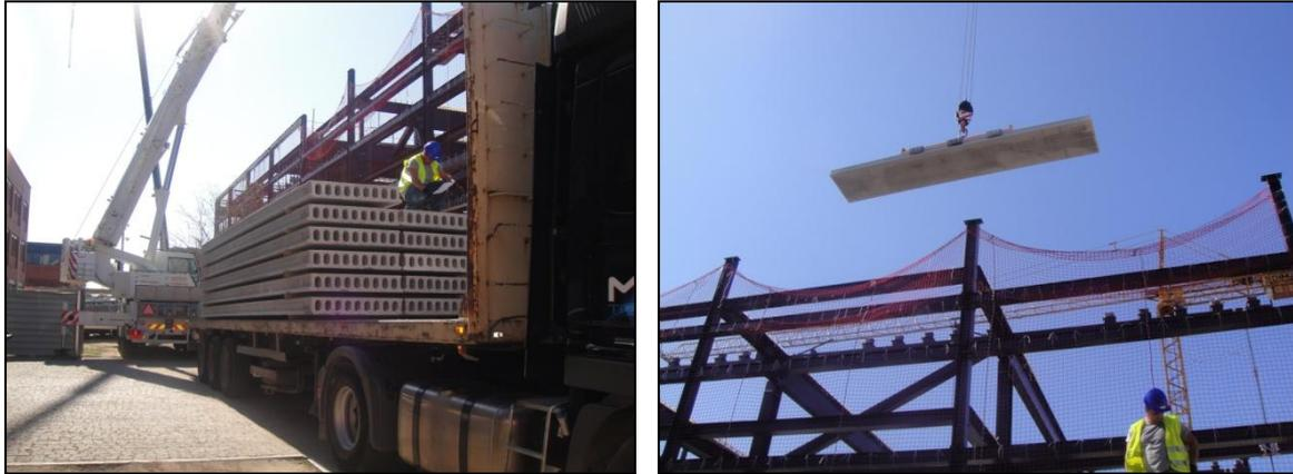
**Figuras 56 e 57-** Aplicação dos elementos pré fabricados de betão.
