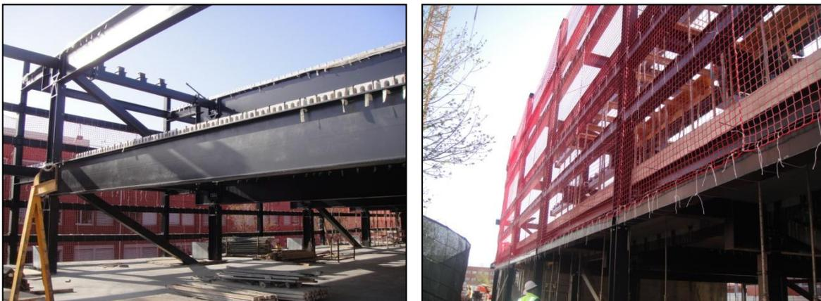
**Figuras 58 e 59-** Superestrutura do CICFANO em elementos metálicos.
