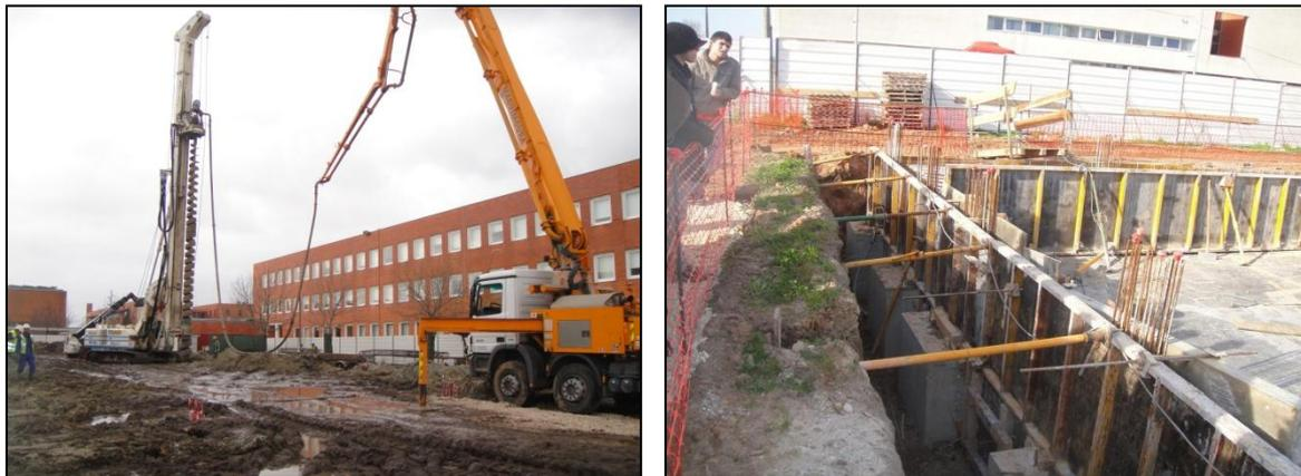
**Figuras 50 e 51-** Solução de estacas de trado contínuo no projeto do CICFANO e ESSUA, respetivamente.
