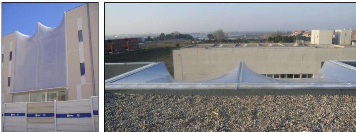
Figuras 74 e 75- Parte da cobertura da ESSUA em ETFE.
