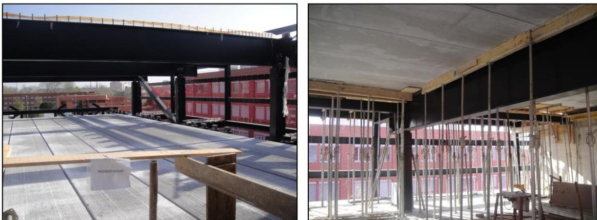
**Figuras 54 e 55-** Solução de betão pré-fabricado no CICFANO.
