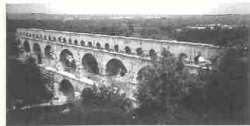
Doc. 2. Ponte-aqueduto do Gard em França.
